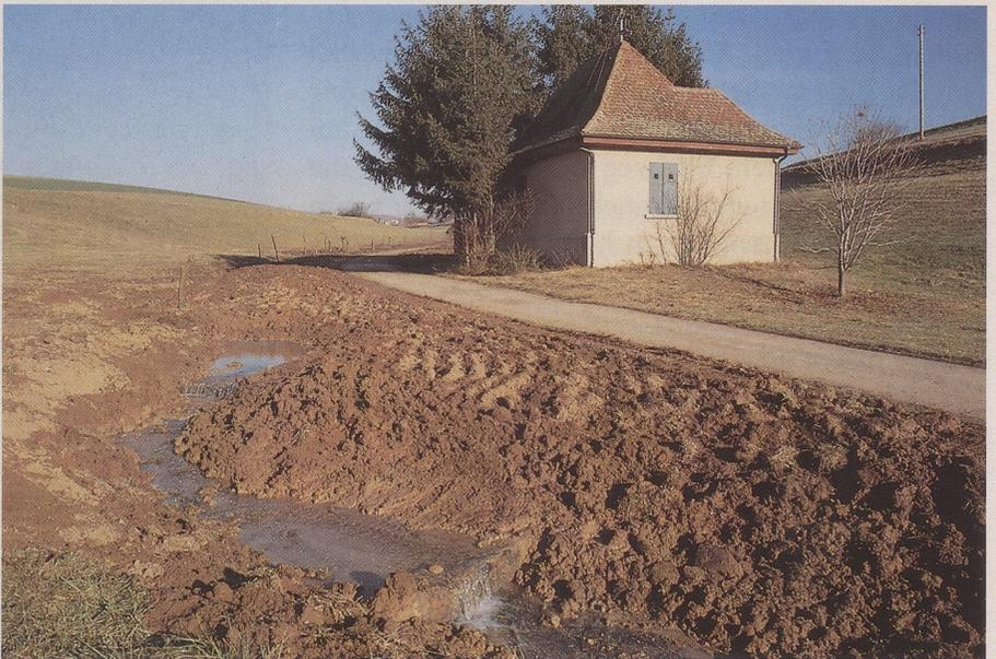
Der Sulzbach nach Abschluß der Erdarbeiten: Deutlich sichtbar sind die möglichst unregelmäßig gestalteten Ufer. Aufgenommen im Dezember 1987.
