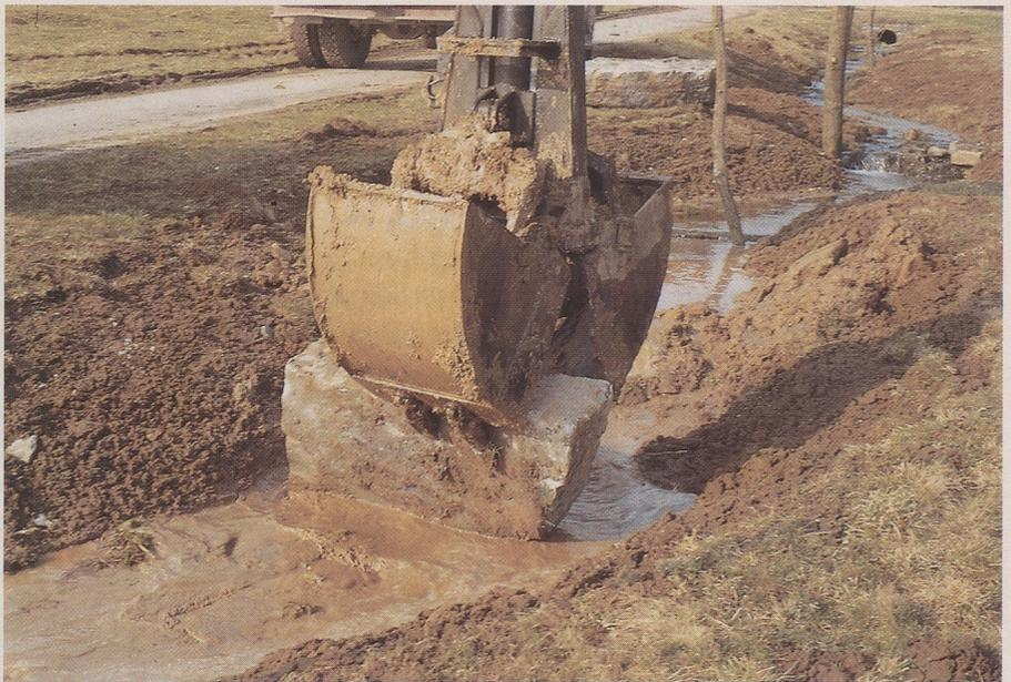
Mit dem Bagger wird ein Schwellenstein gesetzt, um das Gefälle zu vermindern.
