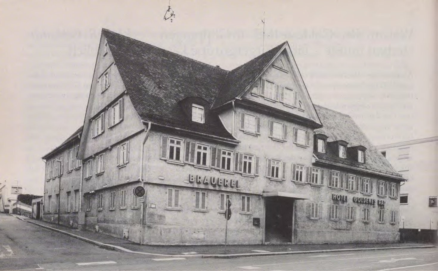
«Goldenes Rad» vor dem Abbruch: Bis in das Erdgeschoß ist die Sichtfachwerkkonstruktion unter dem Putz erhalten. Der markante Zwerchgiebel des 19. Jahrhunderts verleiht dem bedeutenden Gasthaus den in dieser Zeit wünschenswerten städtebaulichen und funktionalen Akzent.
