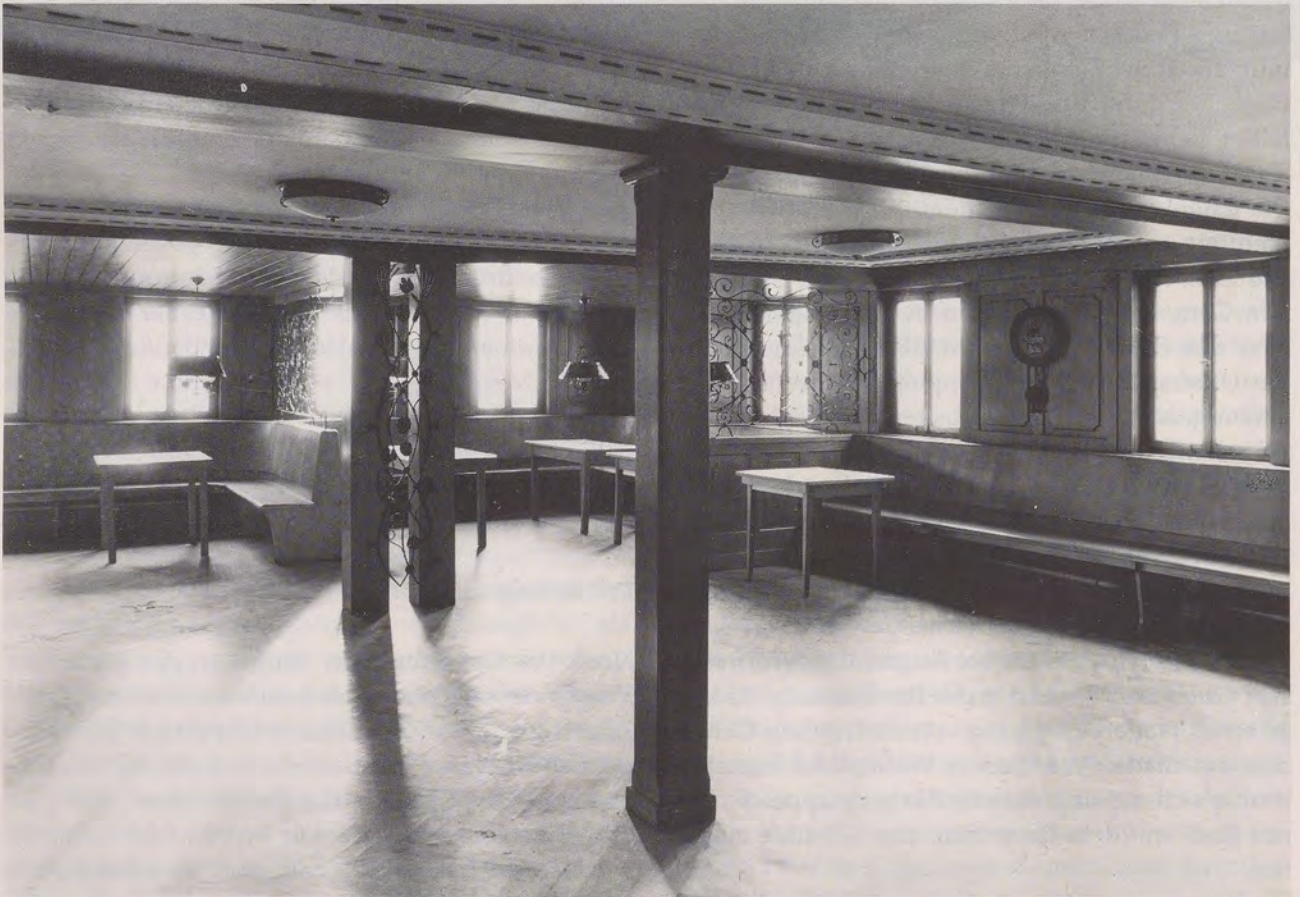
Die vertäfelte Gaststube des «Goldenen Rads». An der Decke erkennt man die gestuften Gipsprofile, über die die Belüftung und Entlüftung der Gasträume erfolgte.
