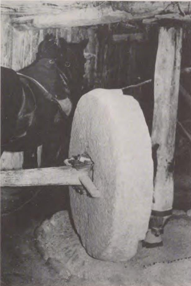
Wie bei einem Göpel muß das Pferd im Kreis gehen. Aber mehr als zwei aufeinander folgende Runden kamen nicht zustande, denn immer wieder mußte das Mahlgut in die Laufbahn des Mahlsteins geschoben werden. Der Mahlgang ist mit Steinen umfaßt, damit sich der Sand oder Gips nicht mit dem Boden vermengen konnten. Mit einem Sieb trennte man das gemahlene Gestein in feines und noch grobes Material. Die Brocken brachte man nochmals in den Mahlgang, das pulverige Fertigprodukt wurde in Säcke geschüttet.
