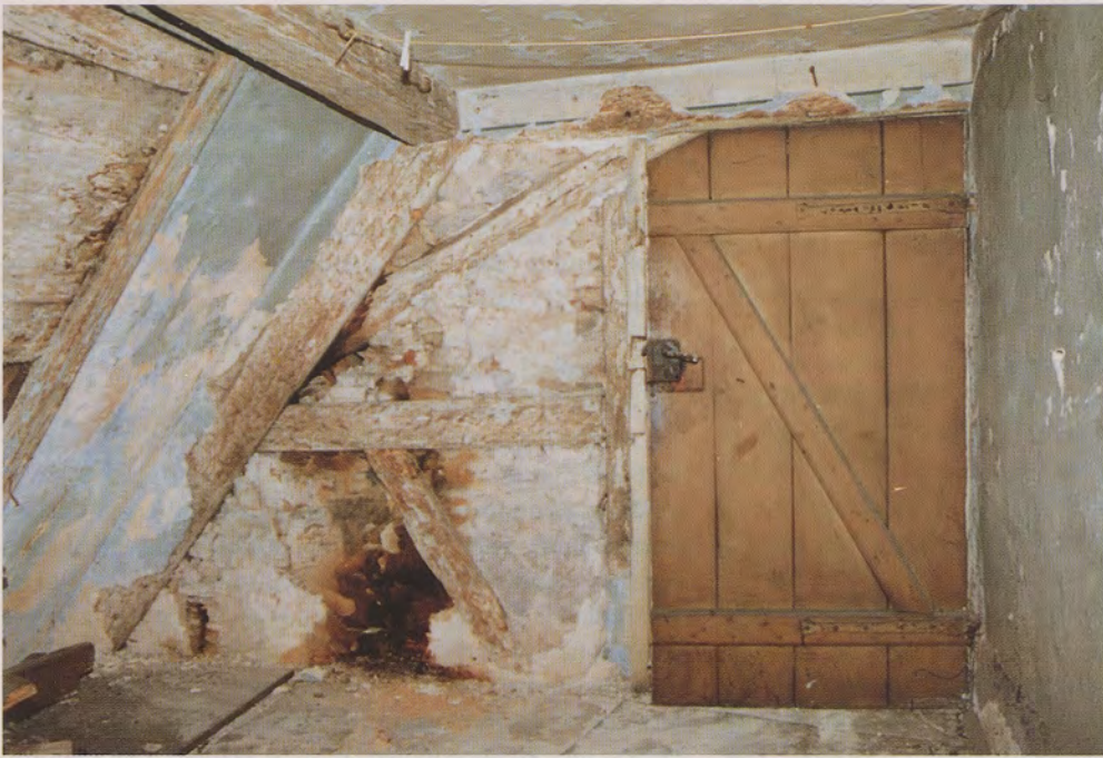
Weberstraße 2, Haupt- haus, 1. Dachgeschoß, östliche Hälfte der Quer- wand, von Norden. Die Wand gehört nicht zum einheitlich abgebun- denen Dachwerk, wurde aber bereits beim Auf- schlagen des Hauses ein- gebaut.
