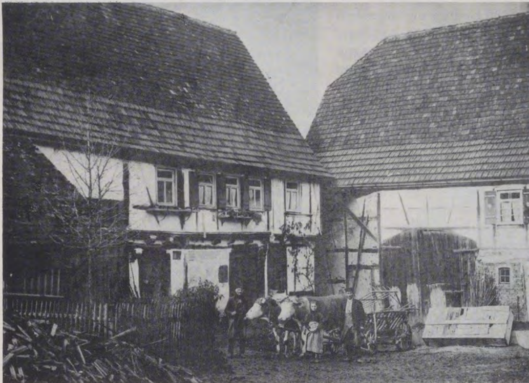
Weihergasse 4 (rechts) und 6: Zwei Ein- häuser, im rechten Winkel zueinander erbaut, ca. 1910 auf- genommen.
