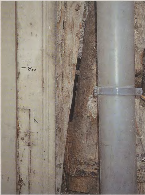
Die Baunaht zwischen Richtstraße 1 (links) und Weberstraße 2 (rechts).
