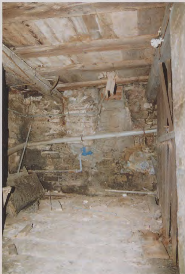
Weberstraße 2, Keller, nordwestliches Viertel, nach Norden. Am rechten Rand angeschnitten der Pfeiler für den Längsunterzug unter der wahrscheinlich originalen Balkendecke (mit Einschubbrettern).
