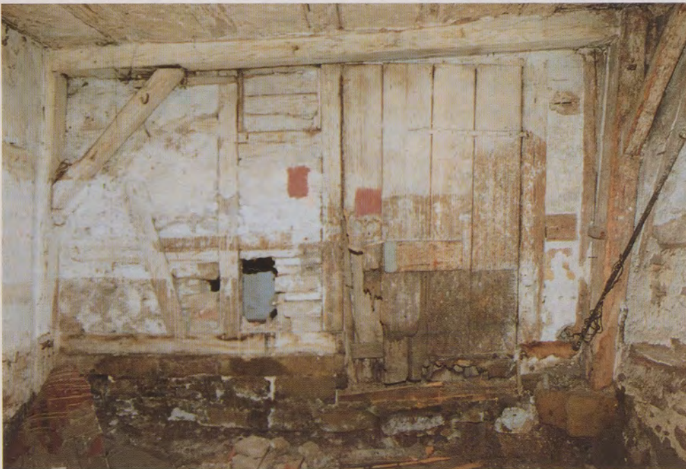
Weberstraße 2, Neben- haus, Blick von der Straße in das Erdgeschoß. Der ehemalige Stall ist ohne eigene Wände in den Winkel von Haupthaus (rechts) und ursprüng- lichem Anbau (hinten) gestellt; die Decke wird von Unterzügen auf Frei- stützen getragen.
