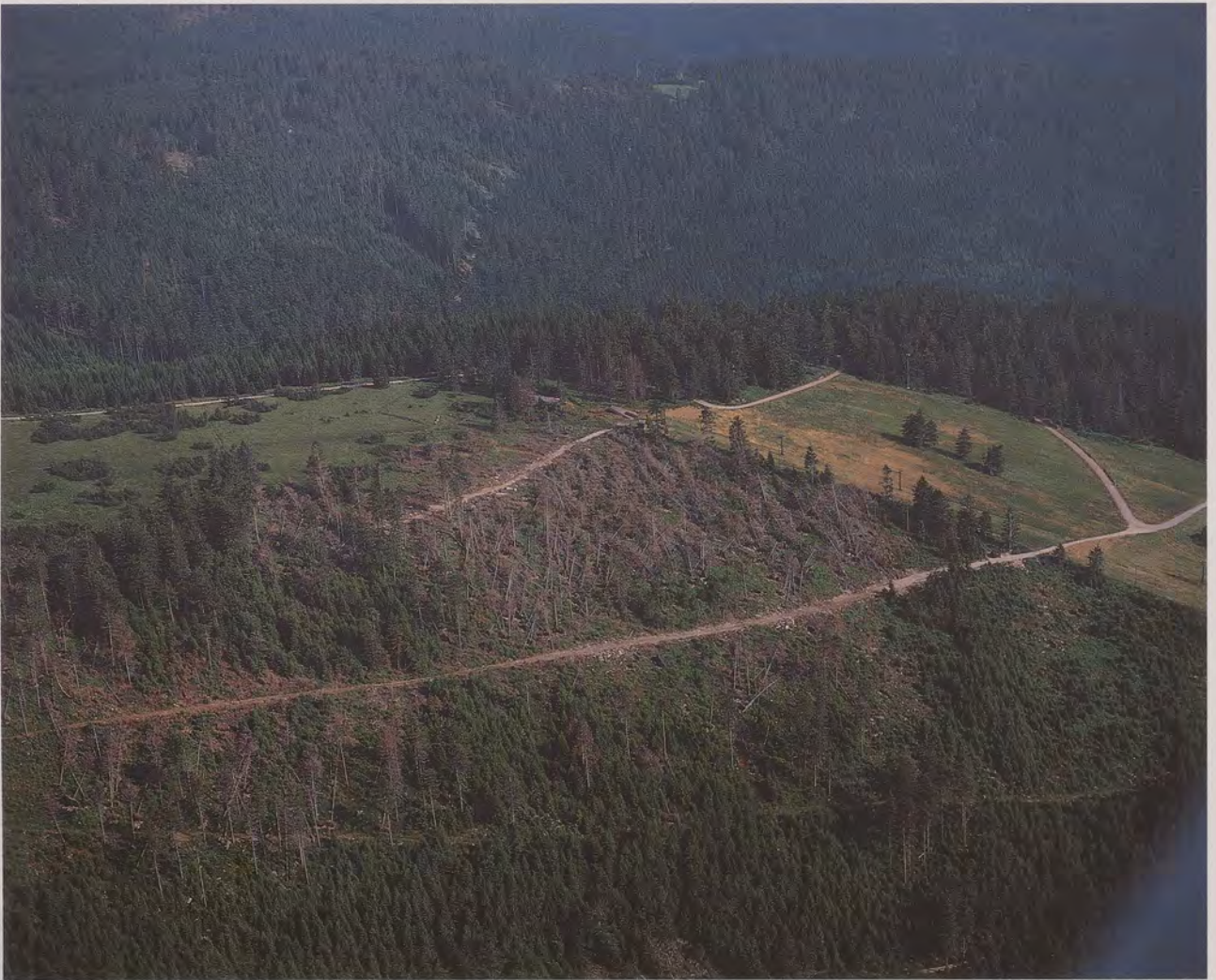
Die Folgen von Stürmen und das «Waldsterben» sind in den Hochlagen des Schliffkopfgebietes an verschiedenen Stellen – hier beim «Ruhestein» – deutlich zu sehen.
