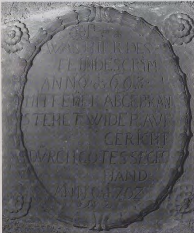
Eine Steintafel an der Kratzmühle aus Oberstenfeld erinnert am Neubau von 1702 an «des Feindes Grim» 1693.
