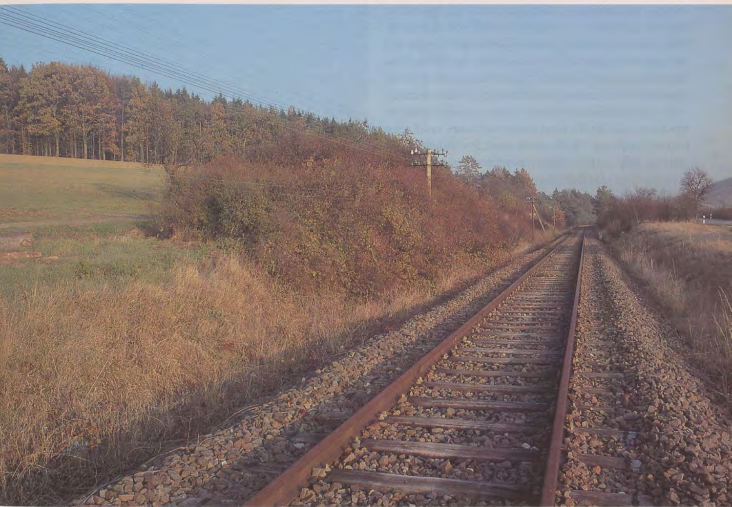
Bahnstreckenabschnitt Ostelsheim-Weil der Stadt mit Hecken und Halbtrockenrasen.
