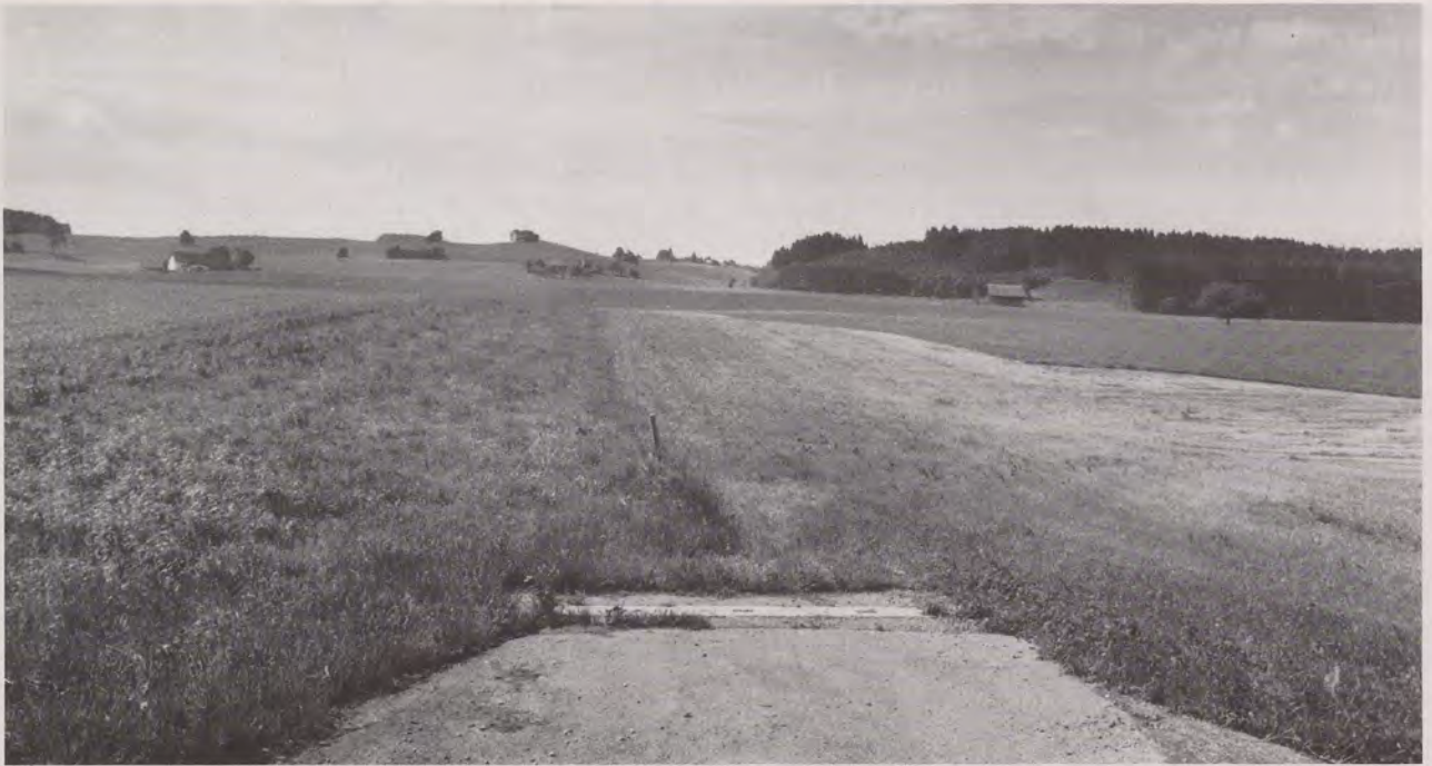
Die ehemalige K 7902, das einzige bisher rekultivierte Stück – Länge 437 Meter – einer Ravensburger Kreisstraße; eines von elf Projekten bei rund 630 Kilometer Kreisstraßen!
