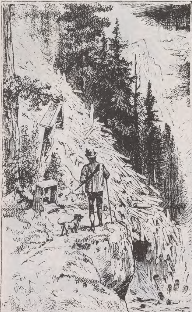
Sogenannte «Scheiterholz-Riese» am Steilhang, eigentlich «Holzstürzen».
