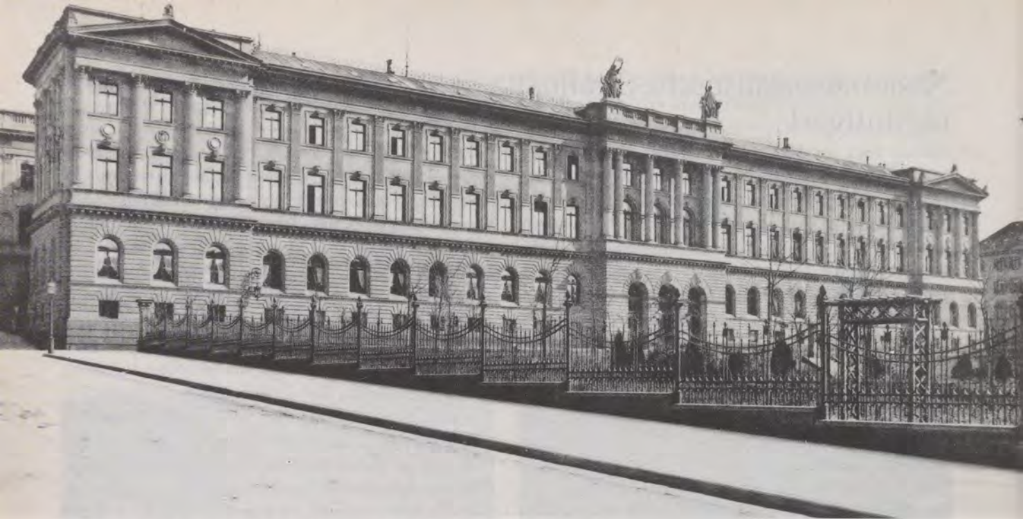
Das Stuttgarter Justizgebäude an der Urbanstraße, wie es von 1878 bis 1944 stand.
