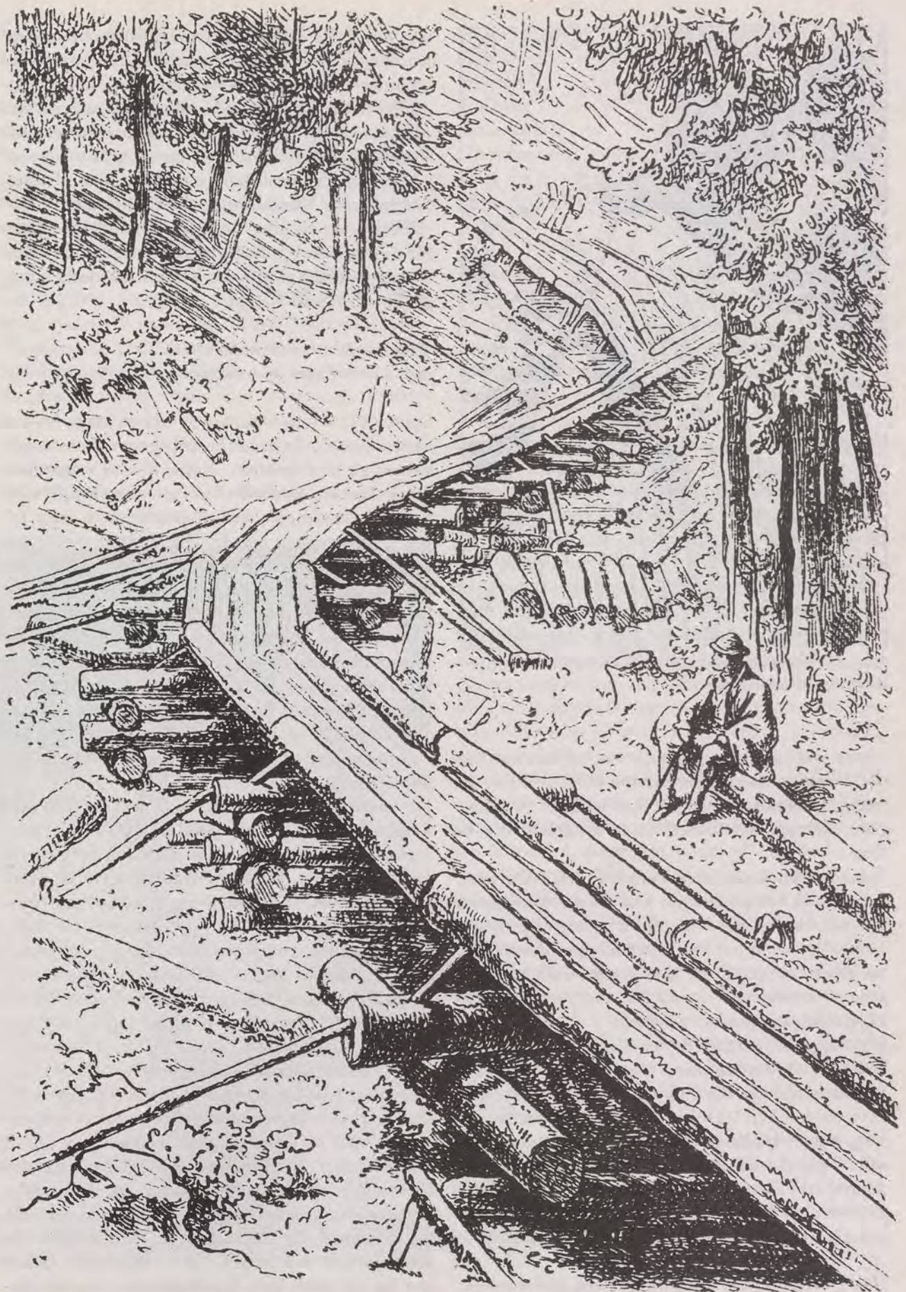
Stammholzriesen geringerer Muldentiefe mit Unterlagen und Abstützungen; im Hintergrund teilt sich die Riese nach oben.
