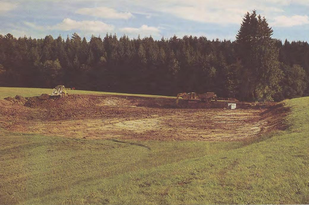
*September 1981: Der Birkensee während der Bauarbeiten; die Mulde wird mit Planiertrauben ausgeschoben und der Damm des früheren Weihers – im Hintergrund – wiederhergestellt.*
