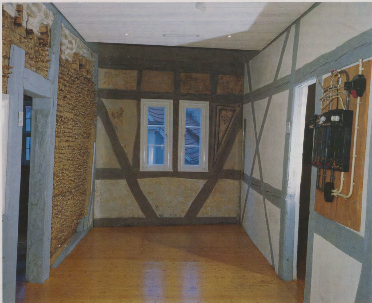
Ein Blick in den Flur im Obergeschoß zeigt die Arbeit der Restauratoren und Handwerker. Links eine freigelegte Pflöckewand, vorne eine freigelegte, rechts eine neu bemalte Wand; die Bodendielen sind neu angefertigt.
