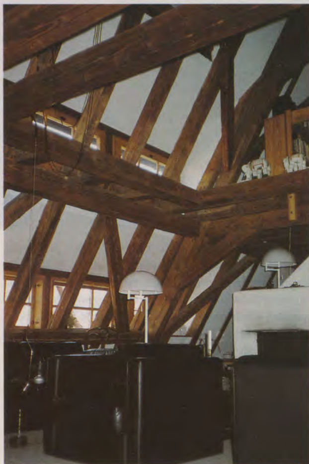
Speichergebäude in der Tübinger Unterstadt. Typisch für solche Bauten sind schmale Fensteröffnungen in den Wänden und kleine Dachgauben in den Dächern. Wohnraum im Dachstuhl mit sichtbarer Holzkonstruktion.
