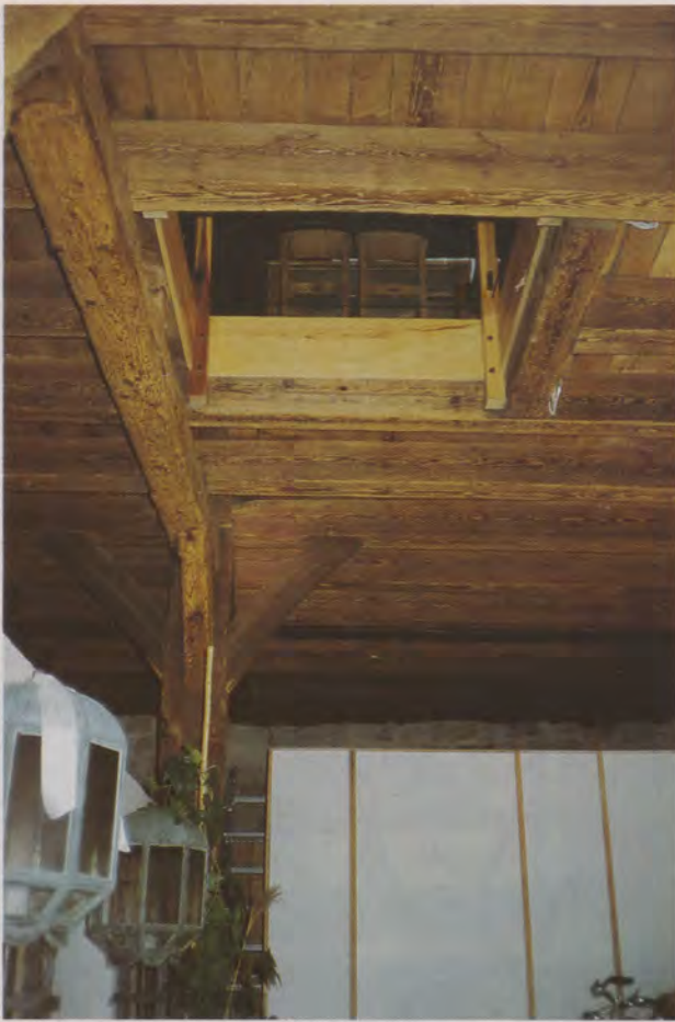
Luke zum Hochziehen und Herablassen von Salzsäcken im Erdgeschoß des ehemaligen Salzstadels; die frühere Funktion des Gebäudes bleibt auch im Innern ablesbar.
