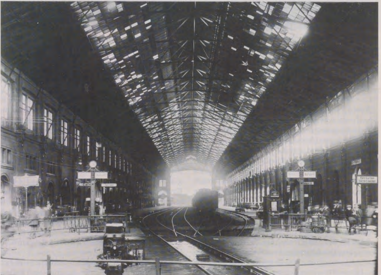
Um die Jahrhundertwende entstandene Innenansicht der südlichen Halle des alten Stuttgarter Hauptbahnhofs, dessen Fassade an der heutigen Bolzstraße erhalten geblieben ist. Im Vordergrund die zum Umsetzen der Lokomotiven benötigte Drehscheibe.
