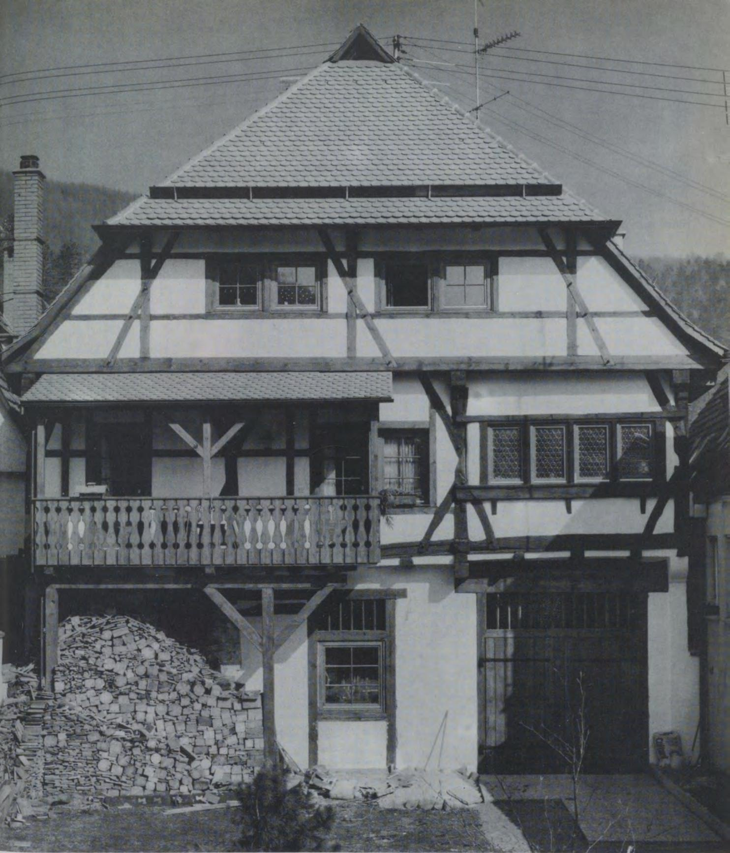
ausgeprägte Fachwerkkonstruktion und birgt eine gotische Stube mit gewölbter Bohlenbalkendecke, teilweise erhaltenen Bohlenwänden und einem nach außen vortretenden Fenstererker. Dies alles war bereits dem Abbruch überantwortet; es konnte schließlich aber doch noch im Zusammenwirken
