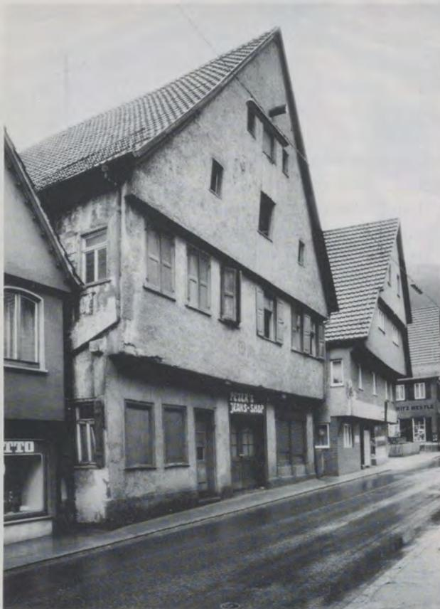
mit gewölbter Bohlenbalkendecke und Fenstererker. . . . Die beiden Giebel stammen von einem Umbau im 17. Jahrhundert. Während der straßenseitige Giebel reiches Zierfachwerk zeigt, wurde der hofseitige Giebel mit einfachem «konstruktivem» Fachwerk errichtet. . . .
