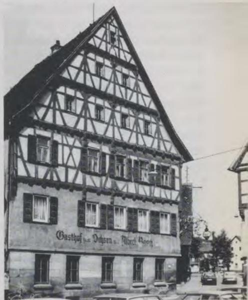
tet, darüber erhebt sich mit liegendem Stuhl ein Steildach mit zwei Ebenen. Das Fachwerk ist fein gegliedert und im zweiten Stockwerk und am Ostgiebel noch gut erhalten, im ersten Stock ist es überputzt. Der Westgiebel mit einem Bund der Tragkonstruktion gehört nicht zur ursprünglichen Substanz des Hauses, das Haus wurde im 17. oder 18. Jahrhundert nach Westen verlängert.
