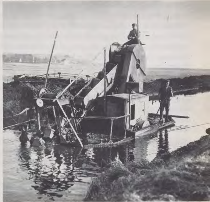
Eimerketten-Bagger wurden 1929 zur Vertiefung der Ostrach eingesetzt. (Foto: Wetzel)
