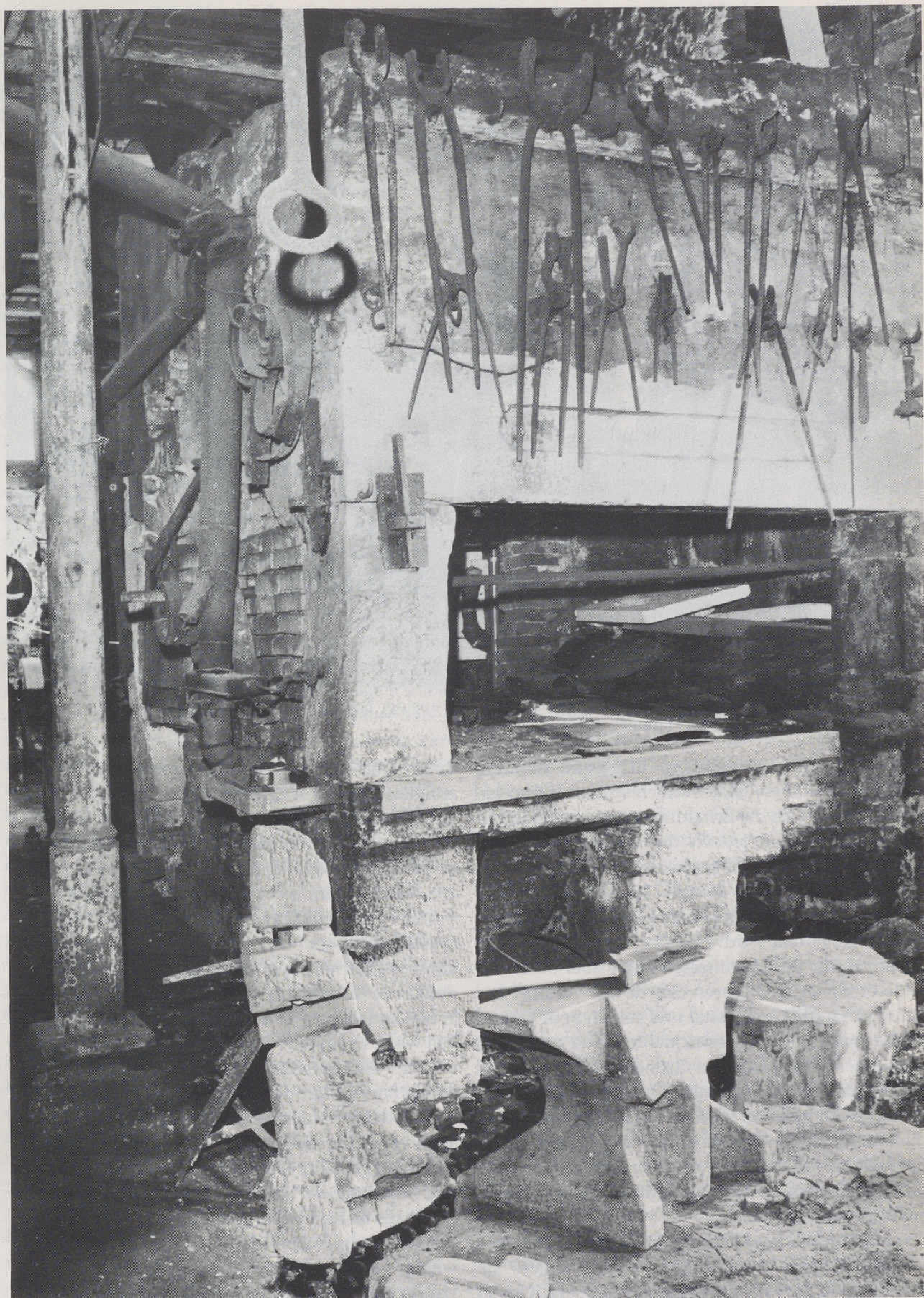
Die Zeit scheint mit dem Hammerwerk angehalten worden zu sein. Die Schmiedezeugen hängen noch über der Esse, ein Hammer liegt auf dem Amboß. Nun aber müssen Bau und Gerät vor Rost und Verfall bewahrt werden.
