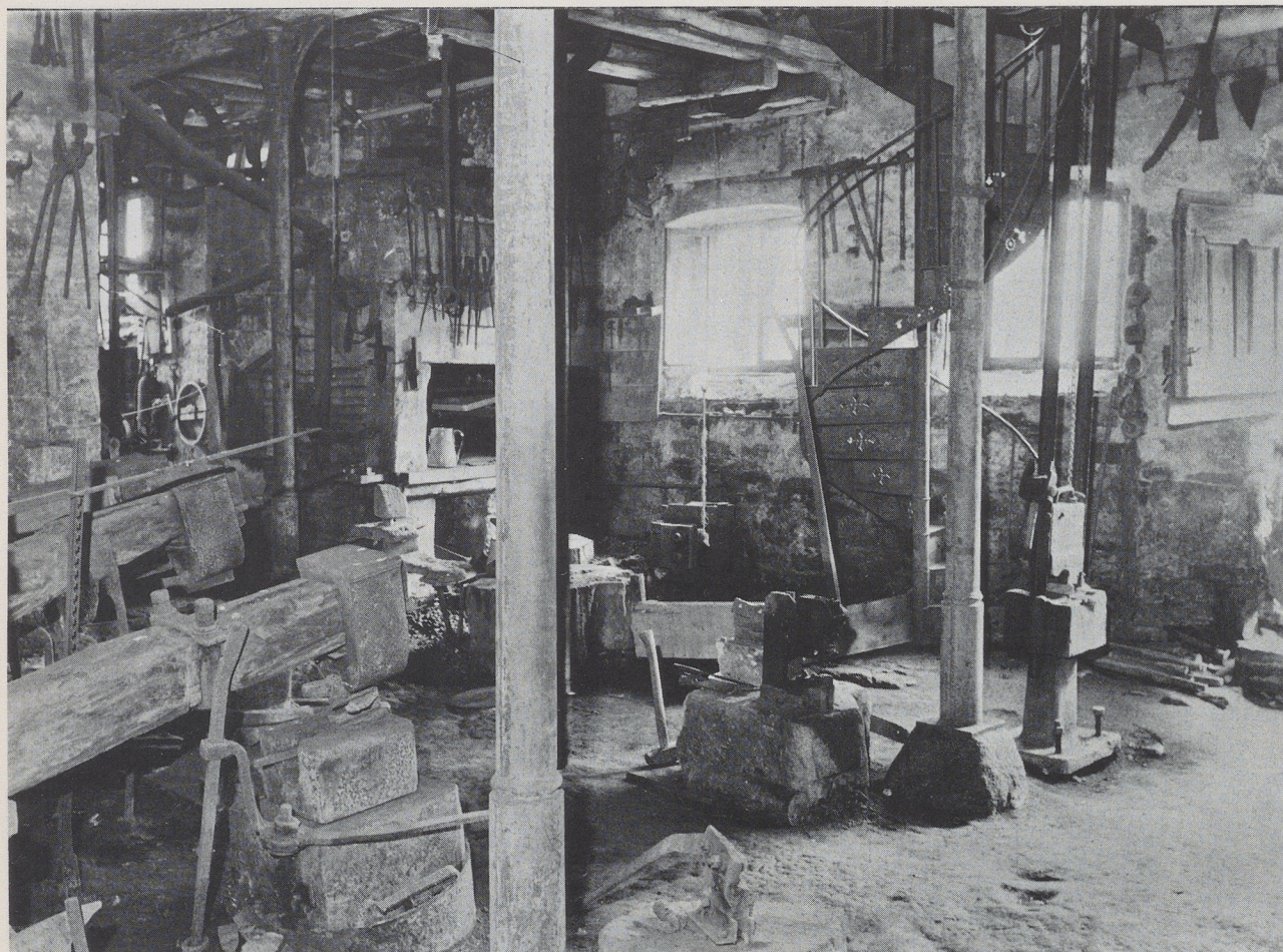
Zwischen den Fenstern erkennt man die Wendeltreppe, die aus der Schmiede zu den oberen Werkstattträumen führt, links die drei schweren Hämmer des Werks.
