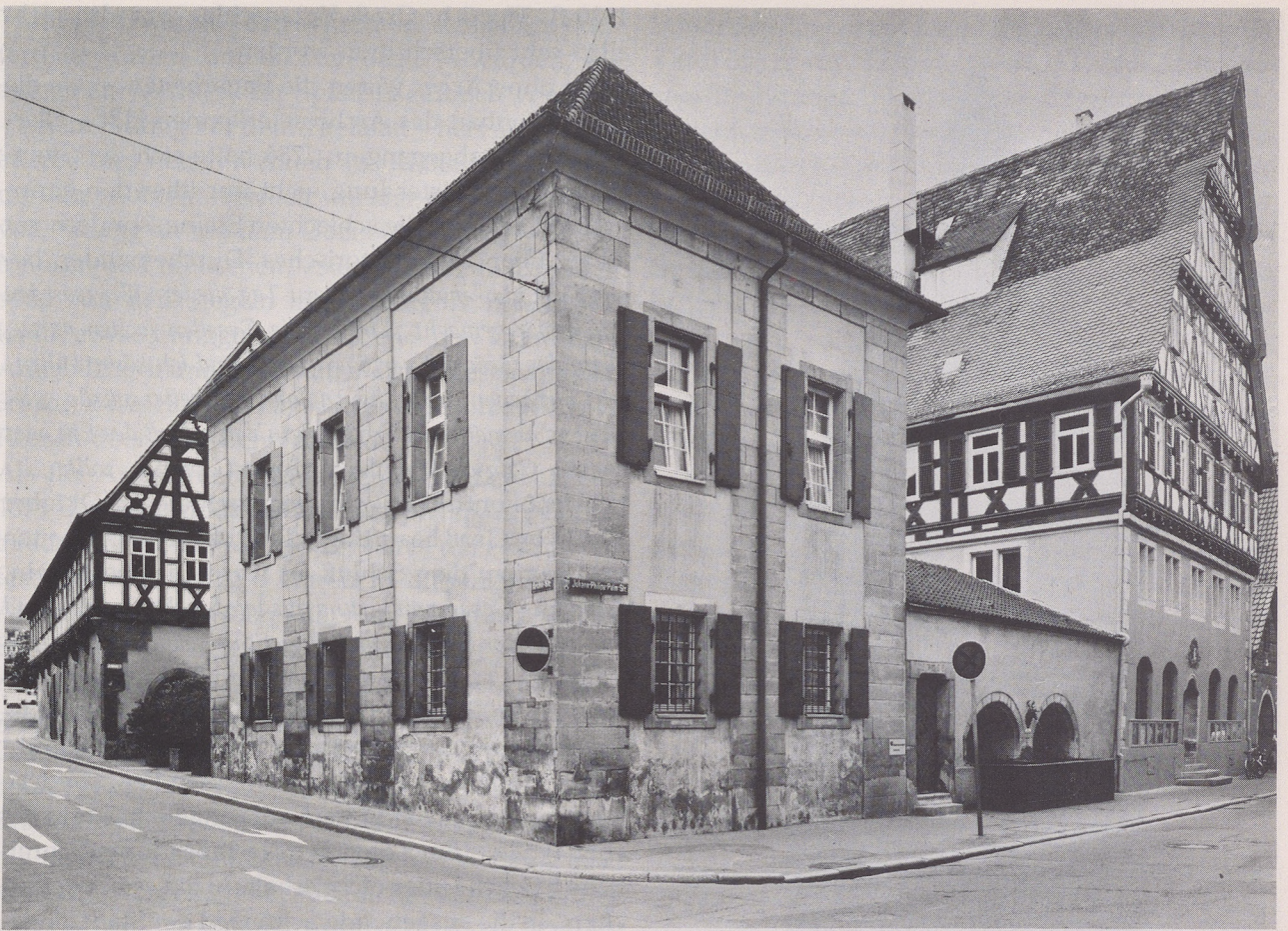
Das Stadtarchiv Schorndorf, 1785–1788 nach den Plänen von Johann Adam Groß d. J. erbaut. Rechts davon das Hauptgebäude des ehemaligen Spitals zum Hl. Geist, links das sog. Meierei-Gebäude des Spitals, 1685–1688 wiedererrichtet (ursprünglich eine Stiftung von 1440).
