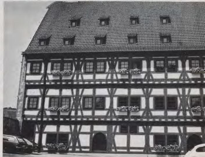
Satteldach wird durch drei Kehlbalkenanlagen in vier Geschosse geteilt. An beiden Giebeln sind in Höhe des obersten Geschosses Krüppelwalme angeordnet, die von Dachreitern aus jüngerer Zeit gekrönt werden.
