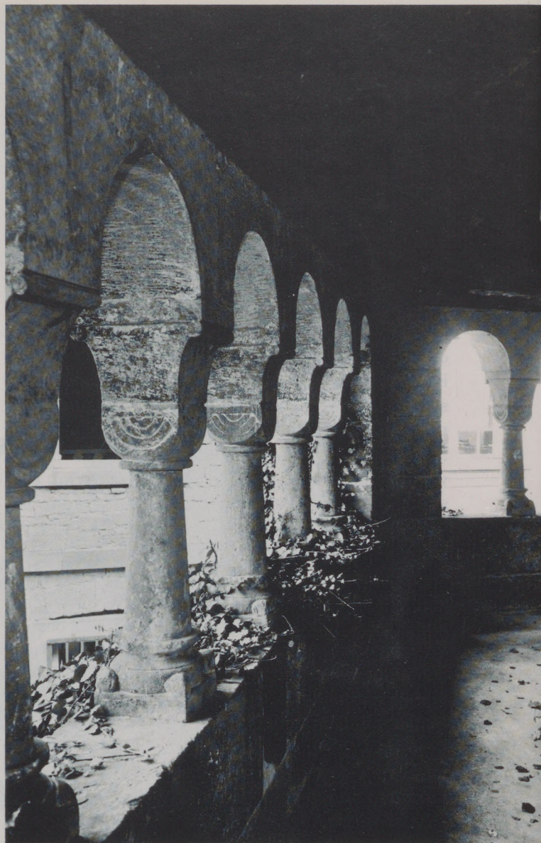
Blick durch die Zwerggalerie der Erhardskapelle zur Neuen Dekanei.
