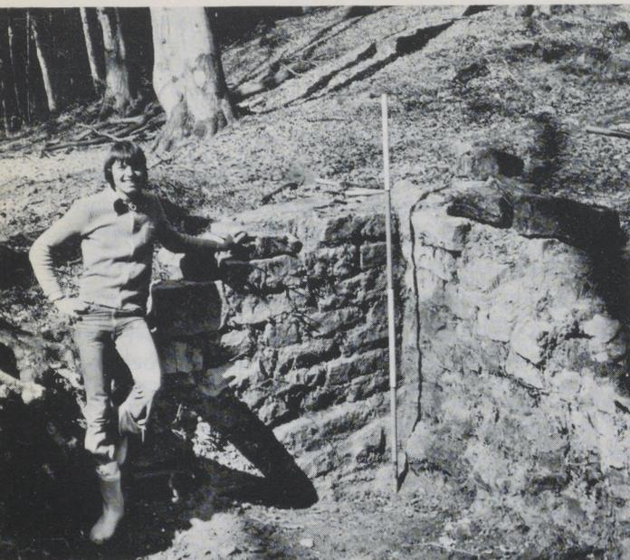
Abb. 2 Die Nordwestecke der Kapelle, Trockenmauerwerk aus Rhät sandstein.
