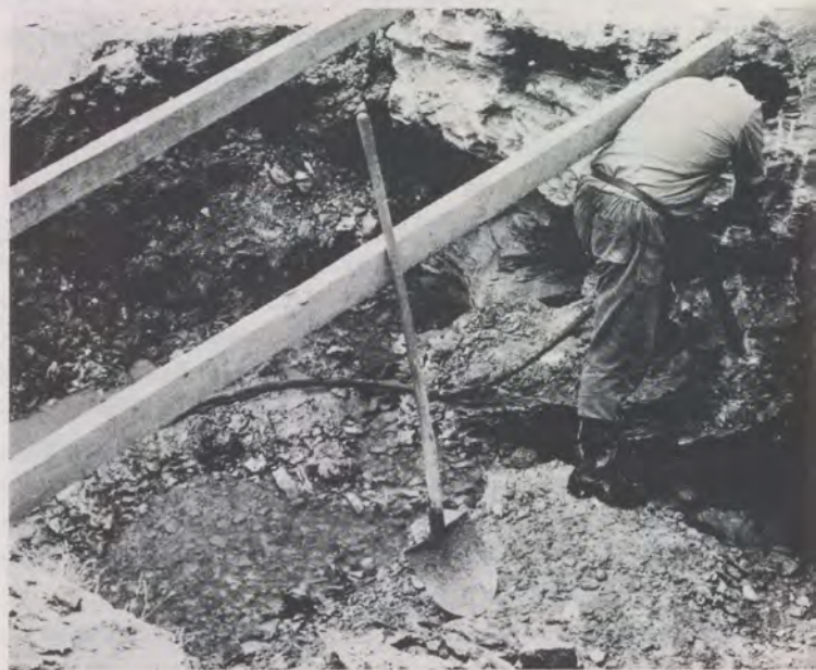
Abb. 2 Kreßbrunnen 1975, freigelegte Gipsfelsen mit Quellschlucht am rechten Bildrand.
