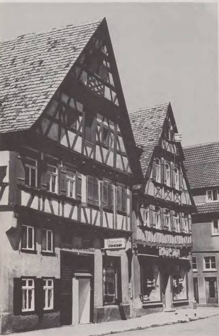
Fachwerkbauten in der Aalener Hirschstraße.
