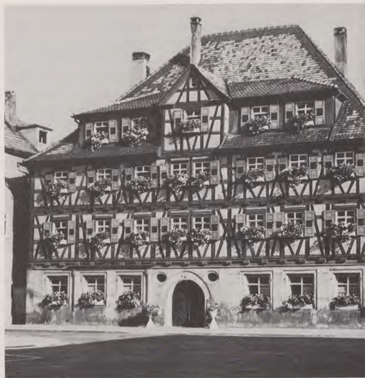
Spital zum Hl. Geist (Fachwerkbau aus der 2. Hälfte des 17. Jahrhunderts) in Aalen.
