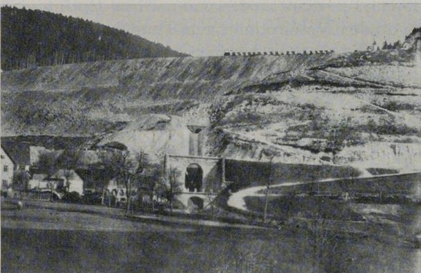
führt, um dann mit einer scharfen Biegung auf die Höhe zu gelangen. Ein Damm ist aufgeschüttet, die Mauern für die Straßenüberführung und für die Glemsbrücke sind fertiggestellt, und das Holzgerüst zum Verlegen der Eisenbrücke ist aufgerichtet. Die Erdaufschüttung, die sich von hier aus rechts der Glems in Richtung Schweizermühle hinzieht, führt auf das Gelände, auf dem später der Leonberger Bahnhof entstehen sollte.
