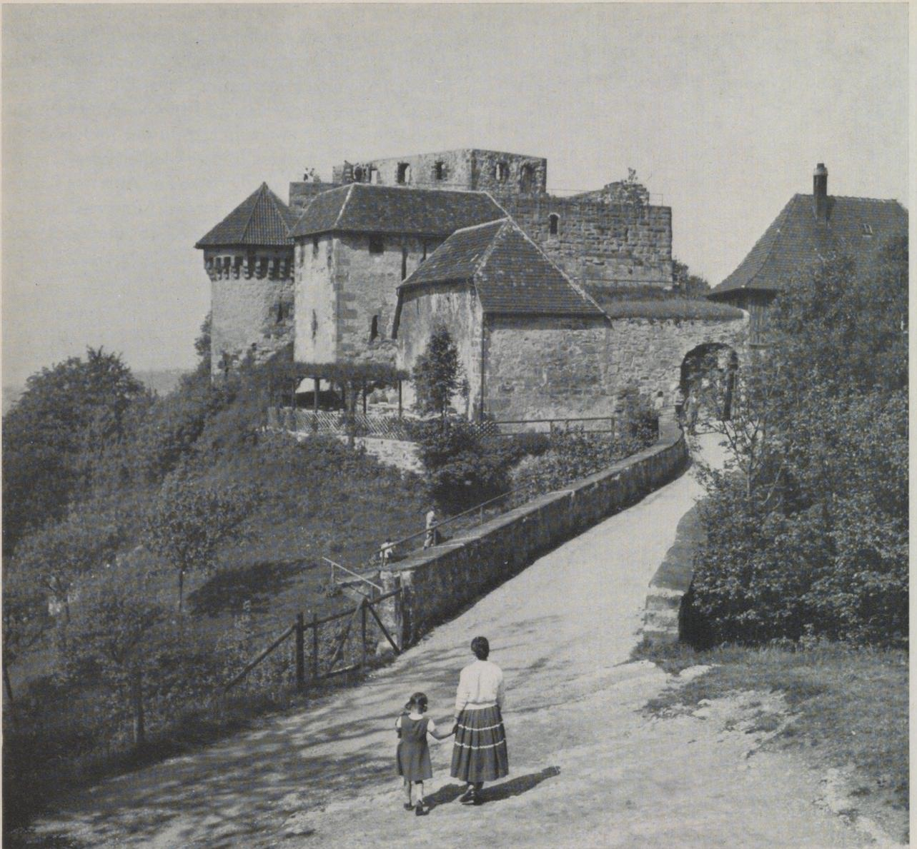
Hohenrechberg. Flankierender Torbau des 15. Jahrhunderts mit zwei Eingängen, Spuren der Zugbrücken und Schießscharten. Der Bau hebt sich von dem staufischen Quaderbau im Hintergrund durch nüchterne Zweckmäßigkeit ab. (Foto Brinzer.)
