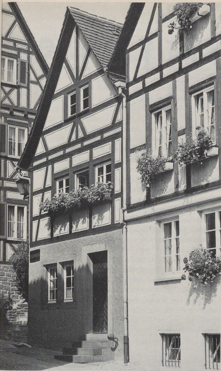
KEPLERhaus in Weil der Stadt (Aufnahme Lückgens).
