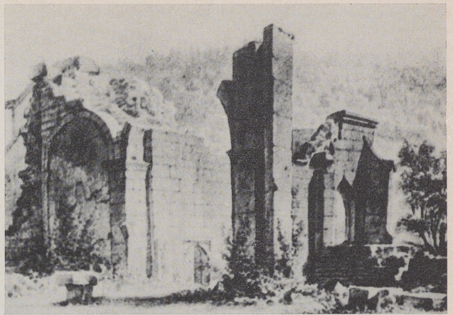
Spätgotische Allerheiligenkapelle, im Nordosten an die romanische Hirsauer Klosterkirche angebaut, in der Mitte ein Vierungspfeiler.
