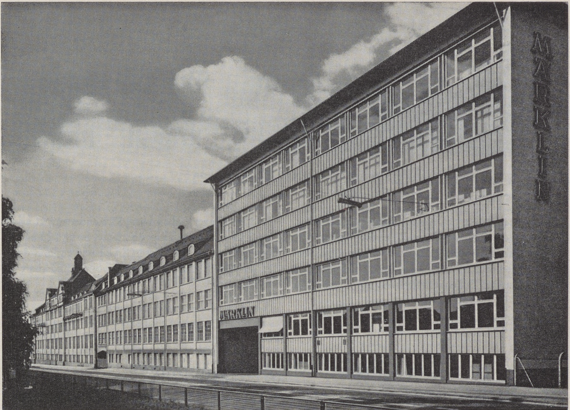
Haus Märklin von der Stuttgarter Straße aus gesehen
