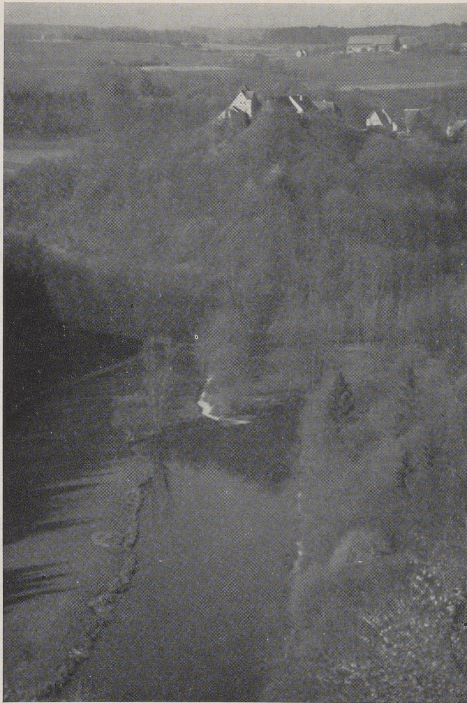
1. Blick vom Bärenstein aus talab mit dem Umlaufberg von Lobenhäusen. In diesem Bereich ist ein Rückhaltebecken geplant
