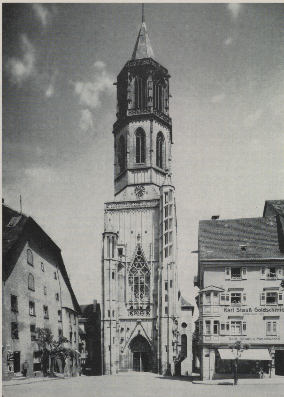
Kapellenturm, Gesamtansicht von Westen
