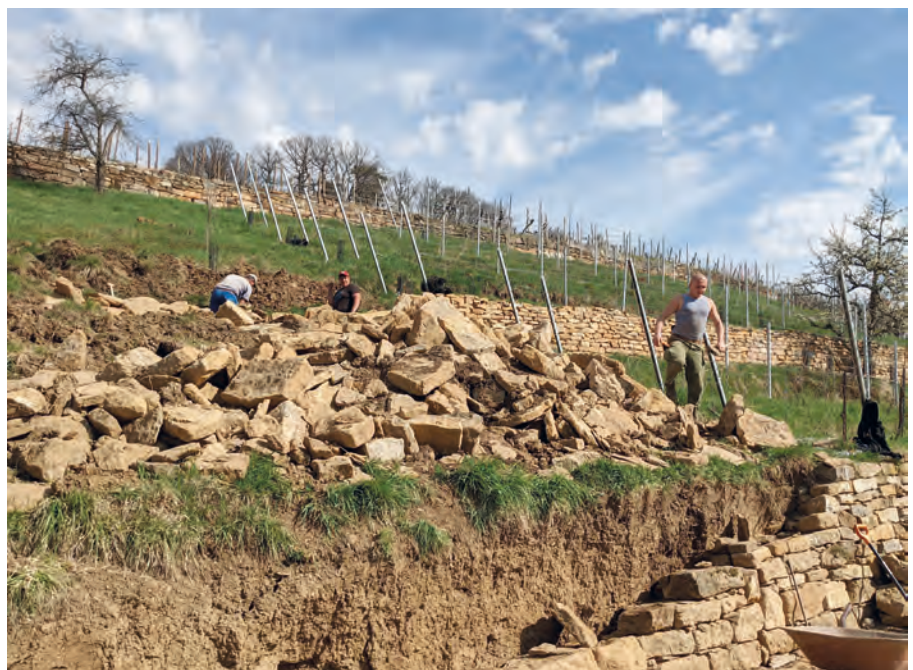
Gerhard Knapp aus Frickenhausen bewirtschaftet nicht nur Weinberge und Streuobstwiesen, sondern hat mit einer kleinen Helferschar auch 240 qm Trockenmauern bei Linsenhofen fachgerecht saniert.
