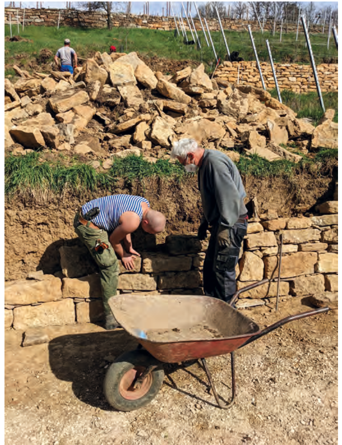
In aufwendiger Handarbeit aufgesetzte Trockenmauern prägen das Bild des Weinbaus in Steillage und sind Lebensraum vieler Tier- und Pflanzenarten.
