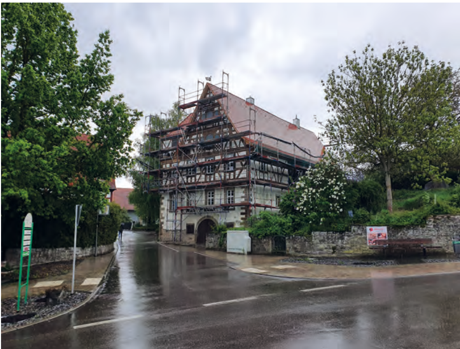
Das Alte Rentamt in Gemmingen im Kraichgau ist ein Fachwerkhaus, dessen älteste Teile aus dem Jahr 1618 stammen.
