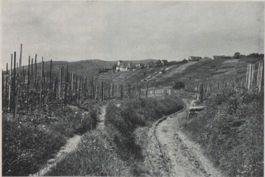
getrepten Muschelkalkhang am Neckar zwischen Hessigheim und Besigheim wurden auf 1 km Länge 52 000 qm Mauerfläche berechnet, für den Stuttgarter Raum (Keuper) wurden auf das Hektar Rebfläche durchschnittlich 5000 qm Mauerfläche geschätzt.
