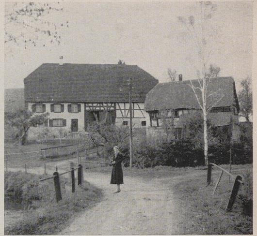
12 a. Neubau des Hauses Schmid
