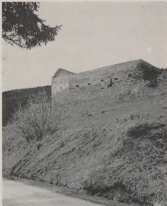
So zeigt sich der alte Bau von Süden her über der Straße. Die spätere Erweiterung ist deutlich an dem helleren Verputz zu erkennen
