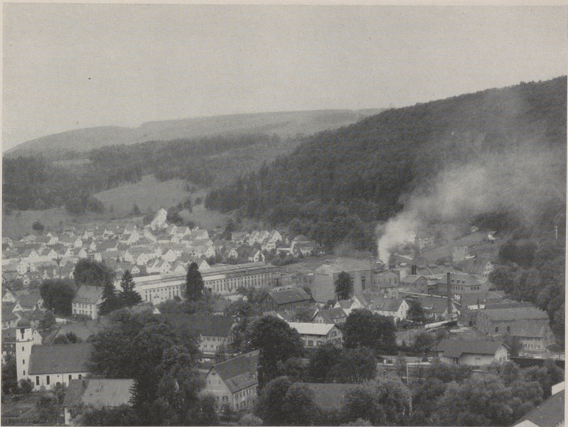
Blick auf das Hüttenwerk heute
