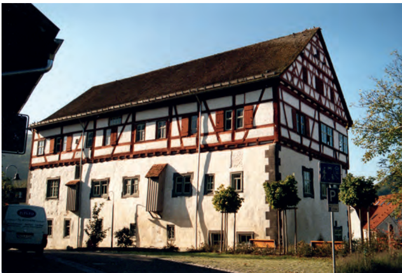
Das Schloss 1997 nach der Sanierung. Von den ursprünglich vier Aborten auf der Bergseite wurden damals zwei wieder angebracht.
