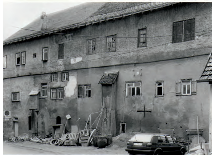
Eher großes Haus als Schloss: 1985 vor der Sanierung
