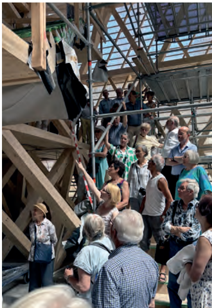
Zum Begleitprogramm gehörte eine spannende Baustellenbegehung an der Oberamteistraße. Architektin Prof. Dr. Elke Nagel erläuterte Intention und Ausführung des heftig diskutierten »Glasbaus« als moderne Ergänzung zu den mittelalterlichen Bestandsgebäuden.
