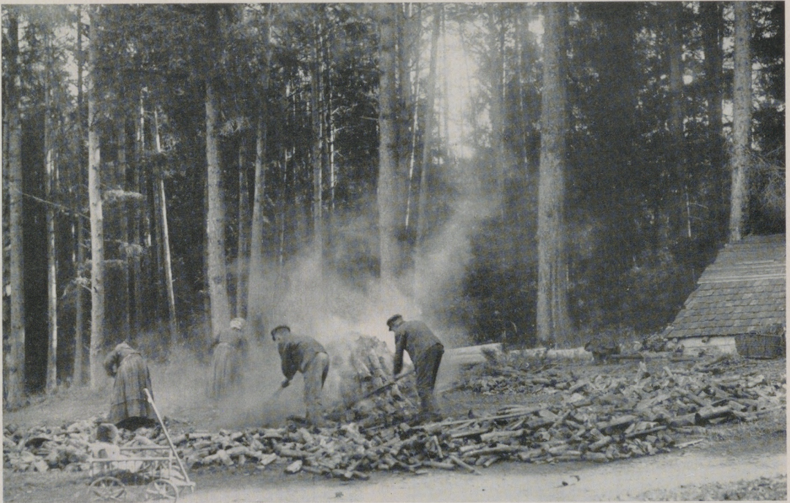
11. Der Meiler wird ausgezogen. Oberreichenbach.
