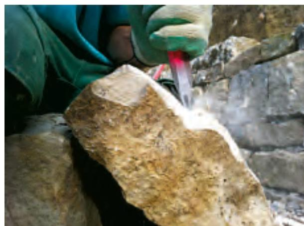
*Bei der Sanierung von Trockenmauern bearbeiten Handwerker die Steine mit Fäustel und Spitzseisen. Mit ihrem «Gesicht» sowie dem oberen und unteren Lager werden die Steine dann präzise auf Kante und Fuge in die Mauer eingepasst. Werden solche Arbeiten in Auftrag gegeben, liegen die Kosten pro Quadratmeter bei 400 bis 500 Euro.*
