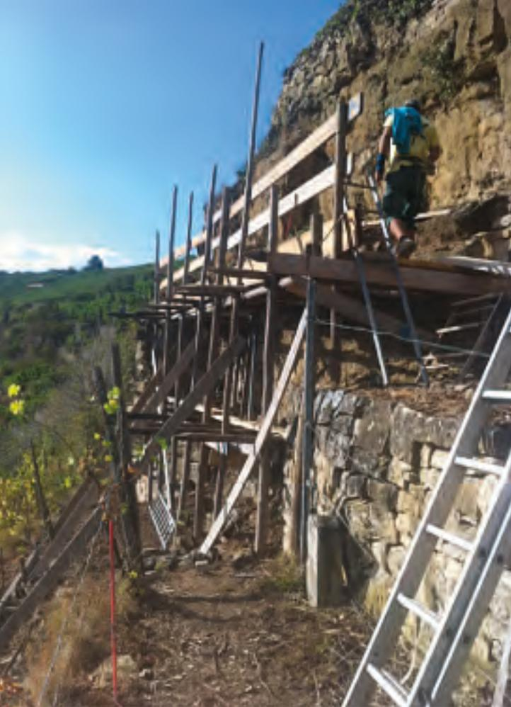
*In Roßwag werden zur Mauersanierung in den steilen Terrassen teilweise Gerüste gebaut und bisweilen sogar Kranen eingesetzt. Rund ein Drittel der Gesamtansichtsfläche von 30.000 m<sup>2</sup> im Kerngebiet «Halde» ist sanierungsbedürftig. Dazu sind pro Hektar und Jahr Investitionen von 10.000 Euro erforderlich.*
