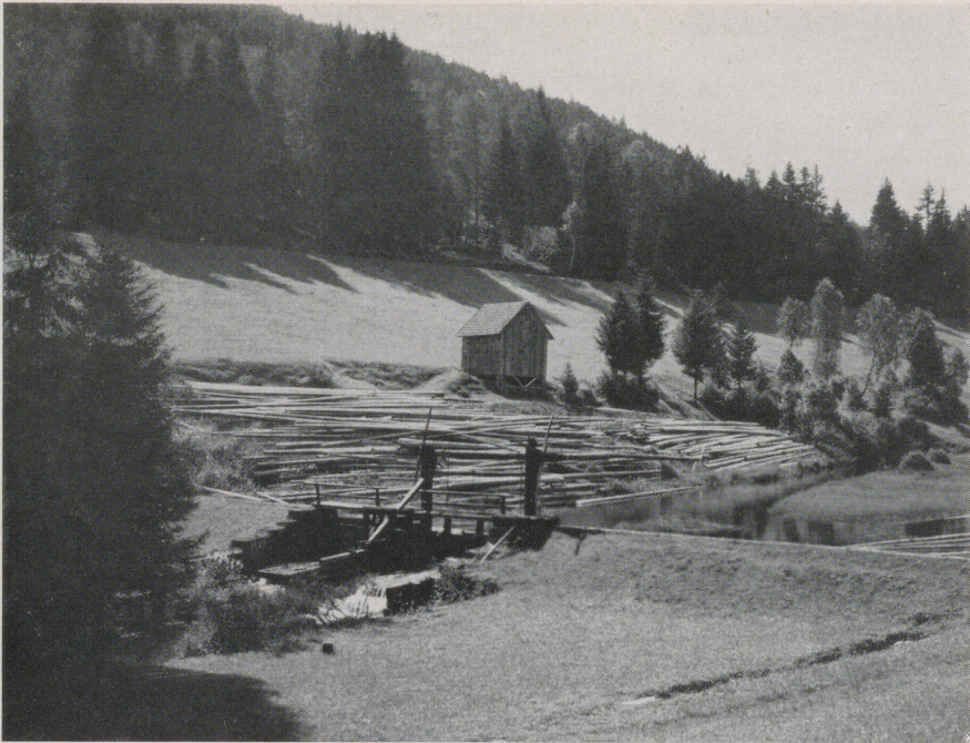
1. Die Stämme liegen auf dem Polterplatz neben der Wasserstube
