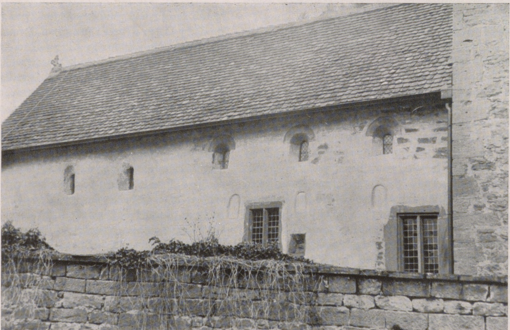
3. Außenwand von St. Candidus (bes. zu beachten die zugemauerten tiefsitzenden Rundbogen)
