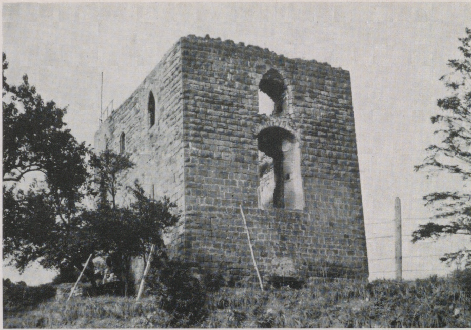
Burg Helfenberg im oberen Bottwartal, Typ des Steinhauses Das Mauerwerk verrät, daß im zweiten Bauabschnitt Trümmer der abgebrochenen früheren Burg verwendet wurden (Fenster später)
