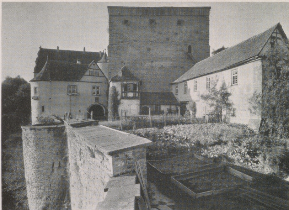
Amlishagen, Typ des Schildmauerburg; der hochgelegene Eingang und der Wehrgang sind erkennbar
