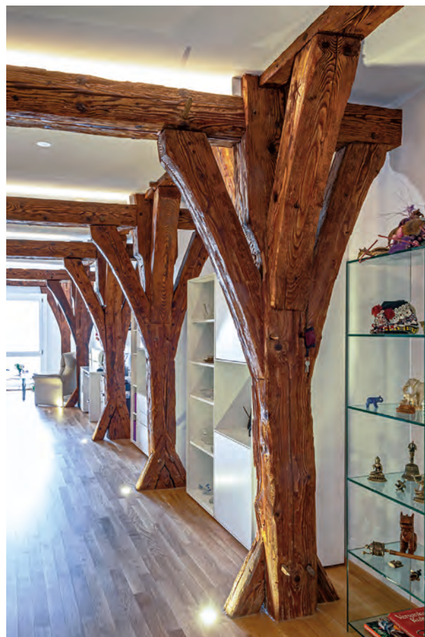
Die Stützenreihe der Tragkonstruktion des Daches blieb auch beim Ausbau des ersten Dachgeschosses zu Wohnungen sichtbar.
