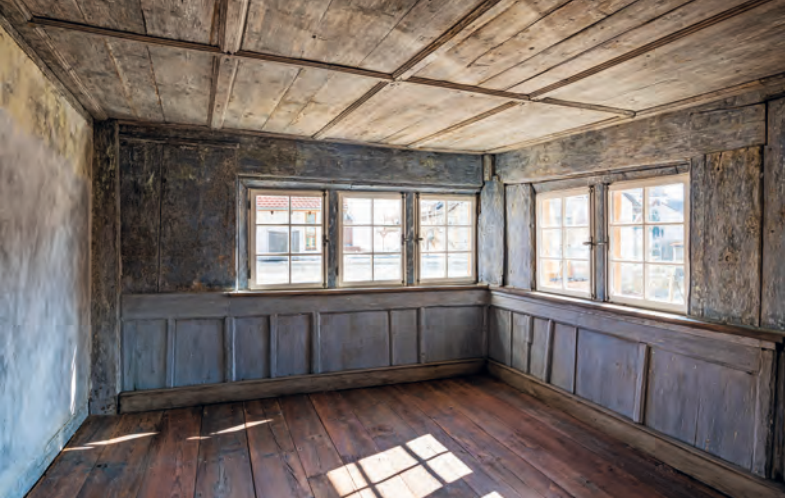
Links: Die Stube mit ihrem ultramarinblauen Anstrich nach der Restaurierung. Das Fensterband wurde nach Befund rekonstruiert. Rechts: Der ehemalige Werkstatttraum im Erdgeschoss mit gesicherten Oberflächen. Die Treppe aus dem 19. Jahrhundert wurde nicht entfernt, sondern kann bei Bedarf wieder die Verbindung ins Obergeschoss herstellen.
