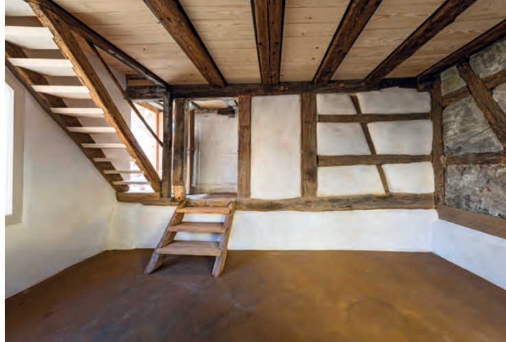
Links: Die Stube mit ihrem ultramarinblauen Anstrich nach der Restaurierung. Das Fensterband wurde nach Befund rekonstruiert. Rechts: Der ehemalige Werkstatttraum im Erdgeschoss mit gesicherten Oberflächen. Die Treppe aus dem 19. Jahrhundert wurde nicht entfernt, sondern kann bei Bedarf wieder die Verbindung ins Obergeschoss herstellen.
