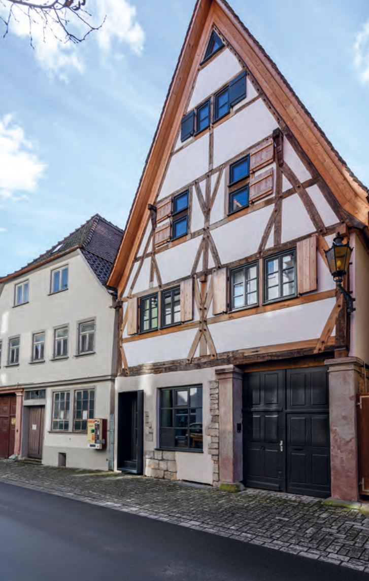
Nach der Sanierung: das bis ins Mittelalter zurückgehende Haus in der Bad Mergentheimer Altstadt zwischen historischen Nachbarn und wenig geglückten Neubauten.
