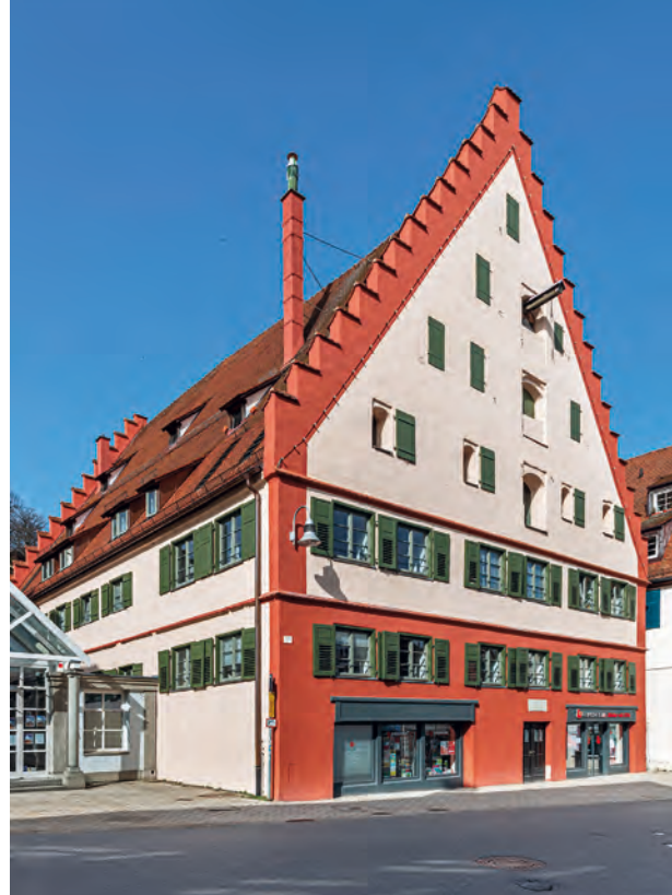
Der stattliche Bau des ehemaligen Salzstadels mit seinem hohen Treppengiebel ist ein aussagekräftiges Zeugnis der Reichsstadtvergangenheit von Biberach geblieben.
