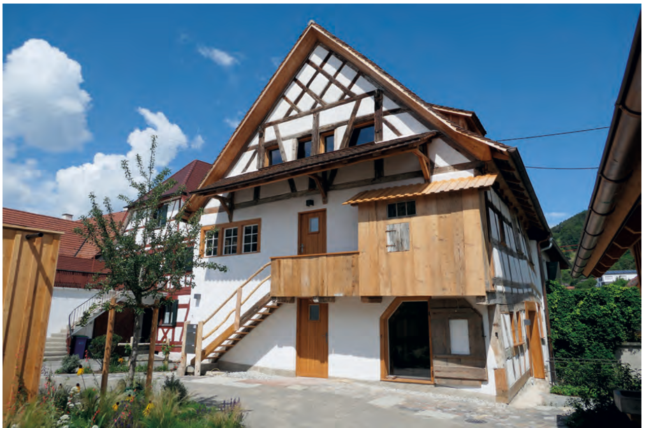
Das ehemalige Rebmannhaus in Sipplingen nach der vorbildlichen Sanierung
