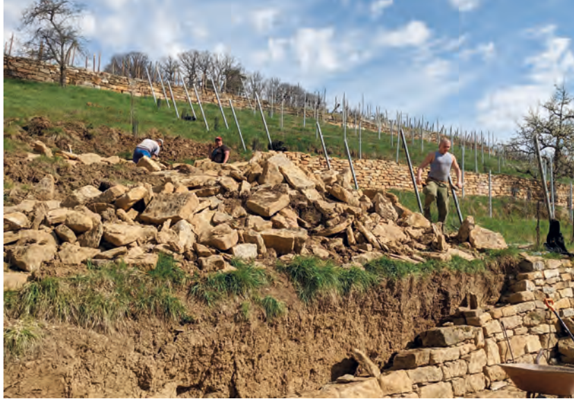
In mühevoller Arbeit erhält der Weinberg von Gerhard Knapp aus Frickenhausen wieder intakte Terrassenmauern und damit sein charakteristisches Gesicht.
