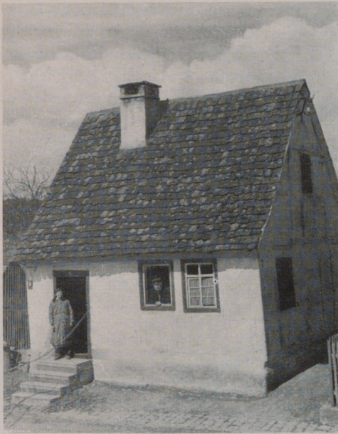
Auf diesem kleinen Wohnhaus wäre ein Dachständer unerträglich. Der Giebelanschluß rechts fällt kaum auf
