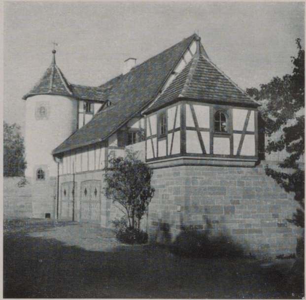
Hier sind keine elektrischen Leitungen zu sehen. Die Freileitung führt bis zu einem Holzmast im Garten und von dort als Erdkabel in das Haus
