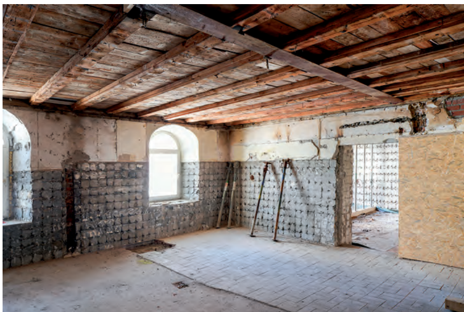
Erdgeschossraum an der Nord-Ost-Ecke: die tragenden Bauteile wurden freigelegt und Einbauten aus dem 20. Jahrhundert entfernt.
