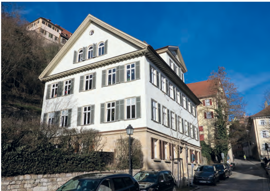
Das Haus Neckarhalde 32 in neuem Putzgewand
