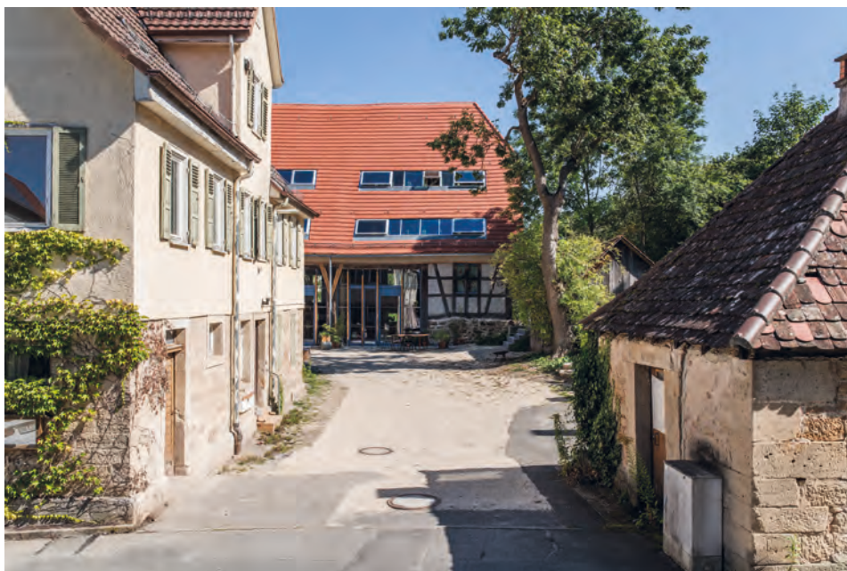
Scheune in Tübingen-Derendingen im Hintergrund, davor steht das ehemalige Schulhaus.
