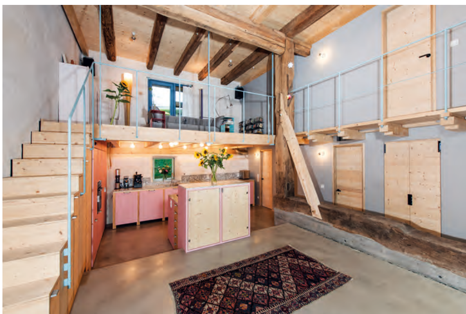
Wohnraum in der ehemaligen Tenne; naturweißer Kalkputz, unbehandelte Holzoberflächen und ein geölter Betonboden prägen die Raumschale.
