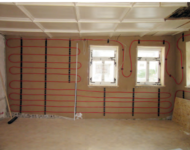
Stube mit Deckentäfer – nach Verlegung der Heizschlaufen
