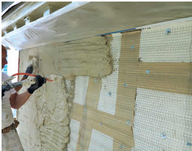
Frühsummer 2018: Aufbringen des Aerogel-Putzes auf die dafür vorbereitete Fassade
