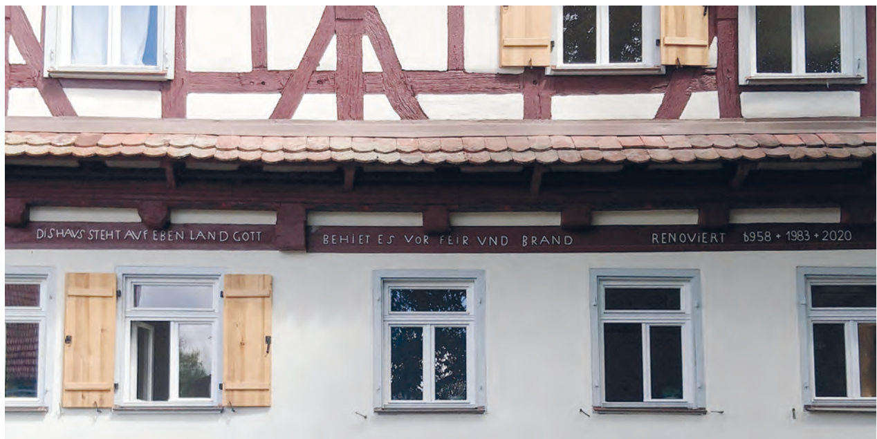
Bauernhaus in Nehren mit Klebdächlein, welches die Balkenköpfe schützt, und dem Segensspruch »Dis Haus steht auf eben Land / Gott behiet es vor Feir und Brand«.
