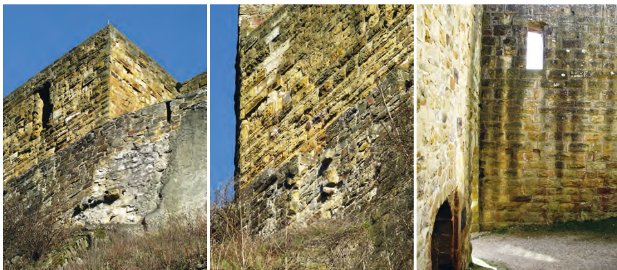
Links: Unverkennbar ist die alte Baunaht am Turm D an der inneren Zwingermauer. Mitte: Ehemaliger Durchgang mit deutlicher Baunaht an der inneren Zwingermauer, oberhalb davon der nachträglich hergestellte Durchgang in der Außenmauer der Kernburg. Rechts: Innenseite der Kernburg-Außenmauer mit dem nachträglich hergestellten Durchgang zu Turm D.
