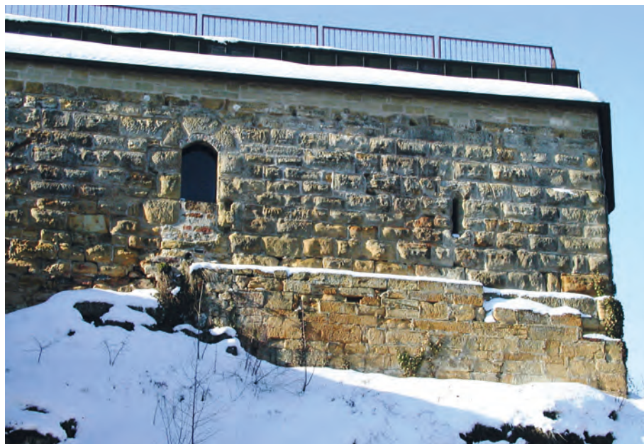
NO-Ecke der Kernburg mit dem «glatten» Quadersockel von Haus II, dem sogenannten «Ostbau».
