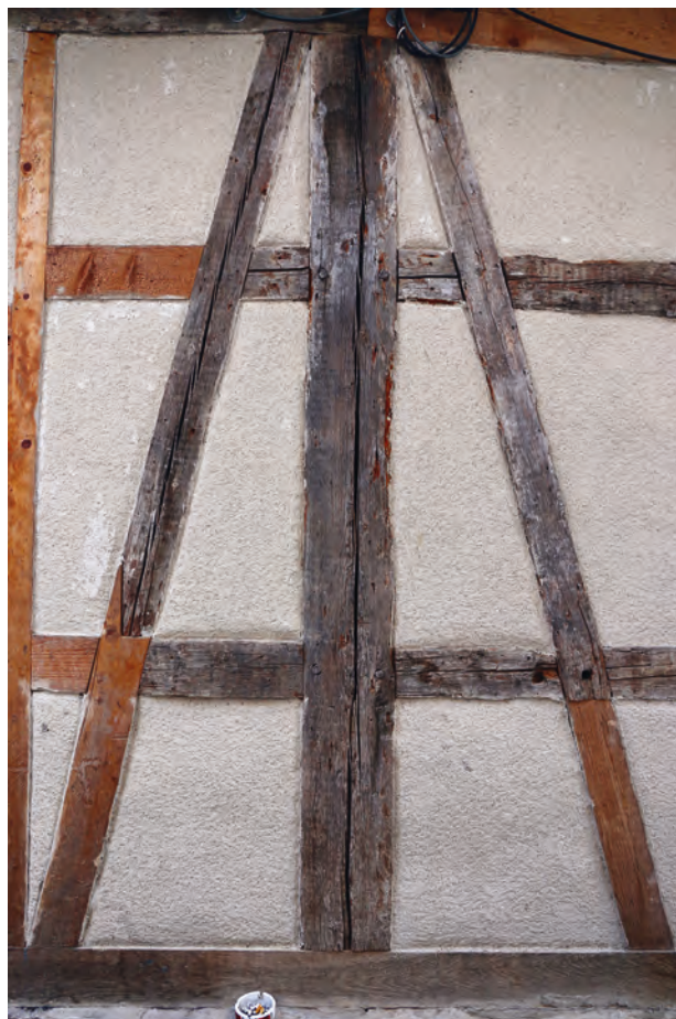
Original erhaltene verzapfte Gerüstaussteifung von 1495 mit eng am Bundständer anliegenden Feldstreben in der westlichen Traufwand.
