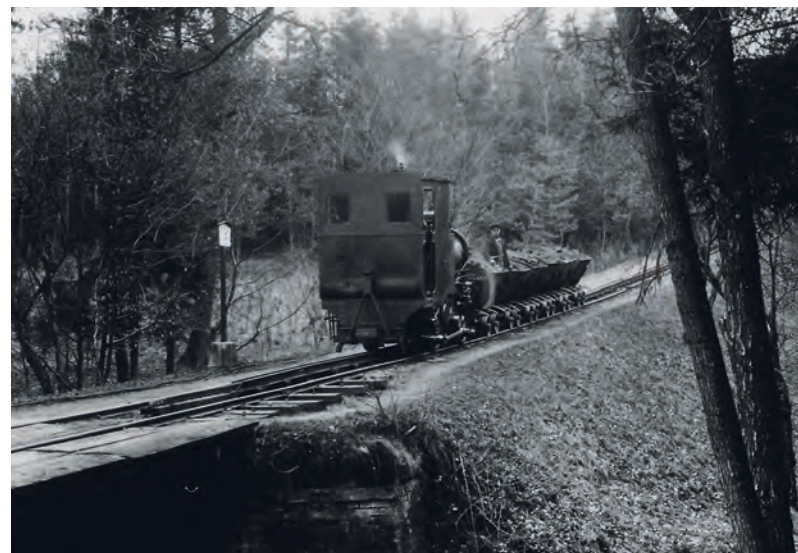
Zwischen den Erzgruben und den Hüttenwerken von Wasseralfingen: ein Zug mit Kipploren über dem Einfahrbereich der Zahnstange, wo das Zahnrad der Lok bei der Bergfahrt eingreifen muss. Georg von Morlok erbaute diese erste Zahnradbahn Deutschlands und erste schmalspurige Eisenbahn in Württemberg. Foto um 1920.
