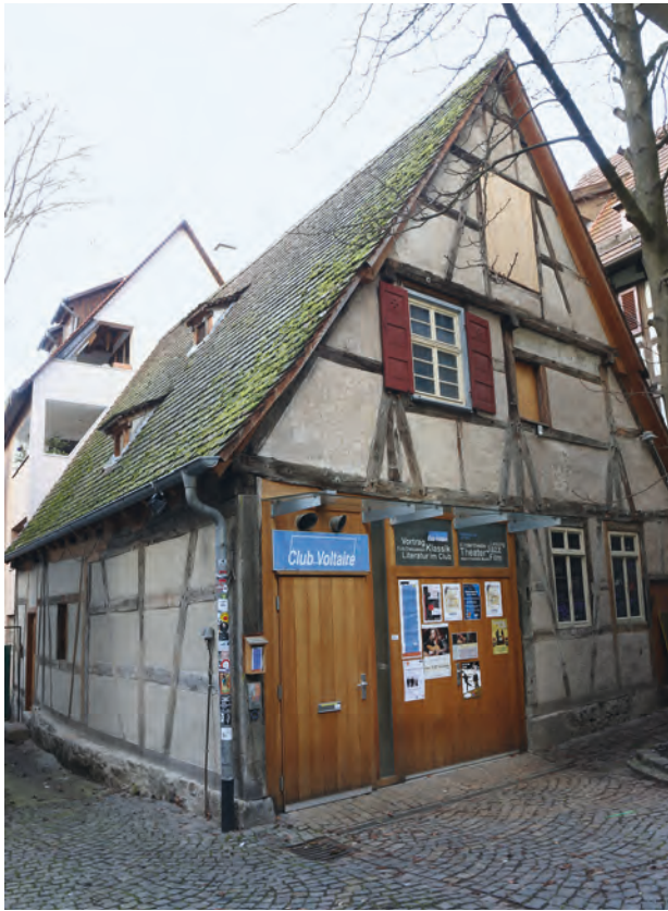
Südwestansicht des Club Voltaire im Herbst 2019 mit freigelegtem und repariertem Fachwerk und neu gestaltetem Zugang.
