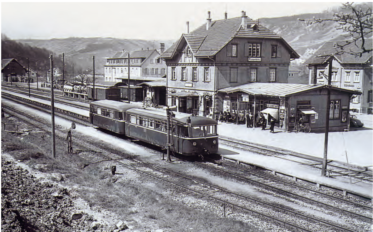
Der Bahnhof Künzelsau 1925 mit einem Schienenbus vor der Abfahrt in Richtung Forchtenberg. Wie bei vielen Stichbahnen war auch für diese Strecke ein Weiterbau, hier in Richtung Ohrnberg, überlegt worden. In Württemberg sollte ursprünglich ein engmaschiges Netz an Nebenbahnen entstehen.
