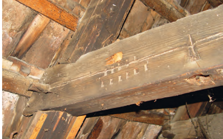
An den Sparren geblatteter, mit Abbundzeichen markierter Kehlbalken über dem zweiten Dachgeschoss. Die hier verwendete, im Frühsommer 1494 geschlagene Fichte stammt laut des am rechten Bildrand sichtbaren «Floßauges» aus dem Schwarzwald und wurde auf dem Neckar nach Tübingen geößt. «Floßaugen» nennt man die schwarzwalddtypische Form der «Wiedlöcher» zum Durchführen der Wieden beim Zusammenbinden der Stämme zum Floß.
