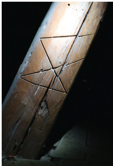
Diese Floßholz-Handelsmarke am Fußende eines Sparrens ist eine Seltenheit im Einzugsbereich der Enz.
