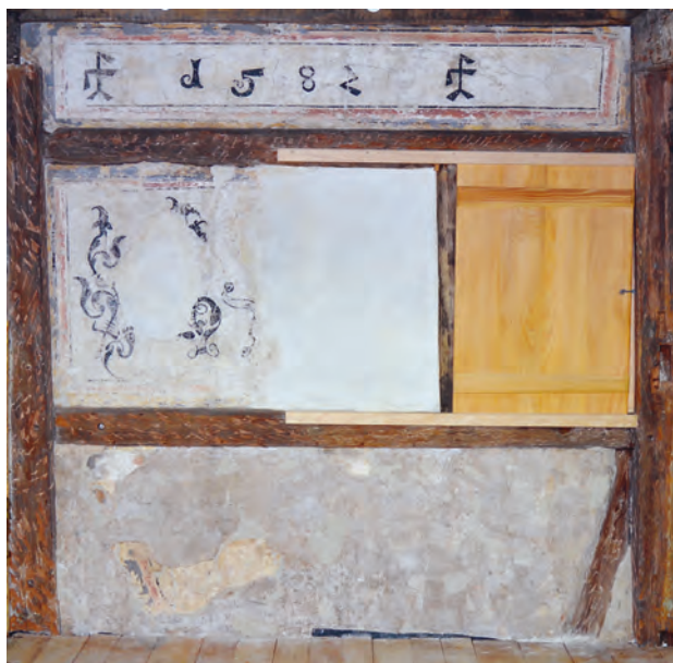
Farbenfrohe Gestaltung der Wand an der südlichen Giebel- wand der südöstlichen Dachkammer. Zu dieser Fassung gehört die im oberen Gefach aufgemalte Jahreszahl mit den Handwerkermarken. In einer späteren Ausstattungsphase wurde die ältere Begleitstrichmalerei mit einer schlichten Graufassung des Fachwerks und gemalter Holzverbreiterung überdeckt.
