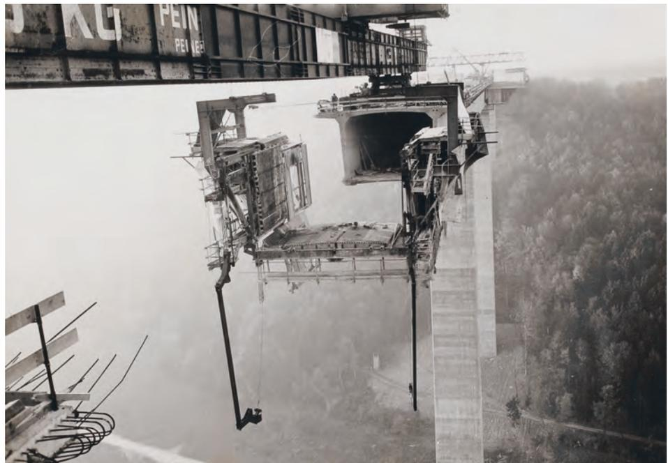
*Die Spannbeton-Hohlkastenbrücke quert die Höhen über dem Kochertal auf einer Länge von 1128 Metern. Baubeginn war 1976; am 18. Dezember 1979 wurde das Brückenkunstwerk dem Verkehr übergeben.*
