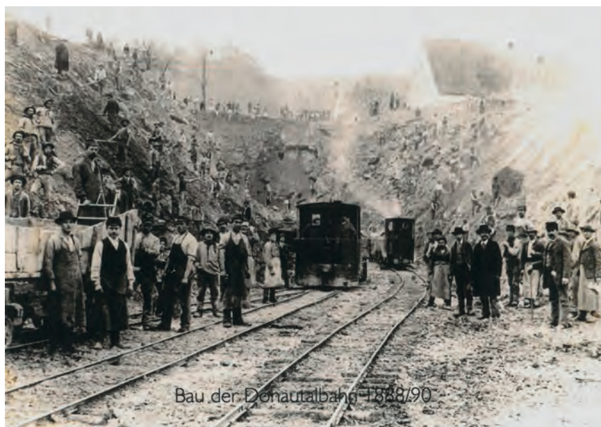
Eisenbahnbau bei Beuron 1888/90. Dort war ein 18 Meter tiefer Einschnitt auszuheben. An den Hängen erkennt man – wahrscheinlich italienische – Arbeiter, die mit Pickel und Schaufel Erde abtragen und das Material in Loren laden. Abgefahren wurde mit Kleinlokomotiven.
