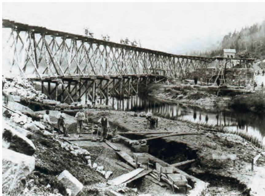
Bau der Donaulbrücke bei Beuron (1889/90). Die halbfertigen Bauteile wurden auf Holzgestelle aufgesetzt und anschließend montiert. Am linken Ufer sind die Brückengerüste bereits weitgehend fertig, am rechten Ufer noch im Bau.
