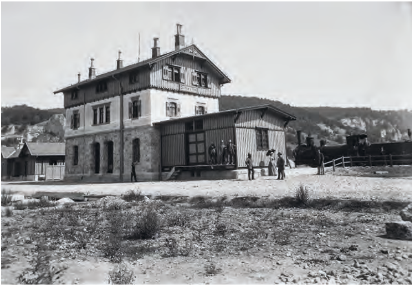
Der Bahnhof Gutenstein im Jahr 1910 mit Dienstwohnung und Güterschuppen; rechts eine Dampflokomotive mit Personal.
