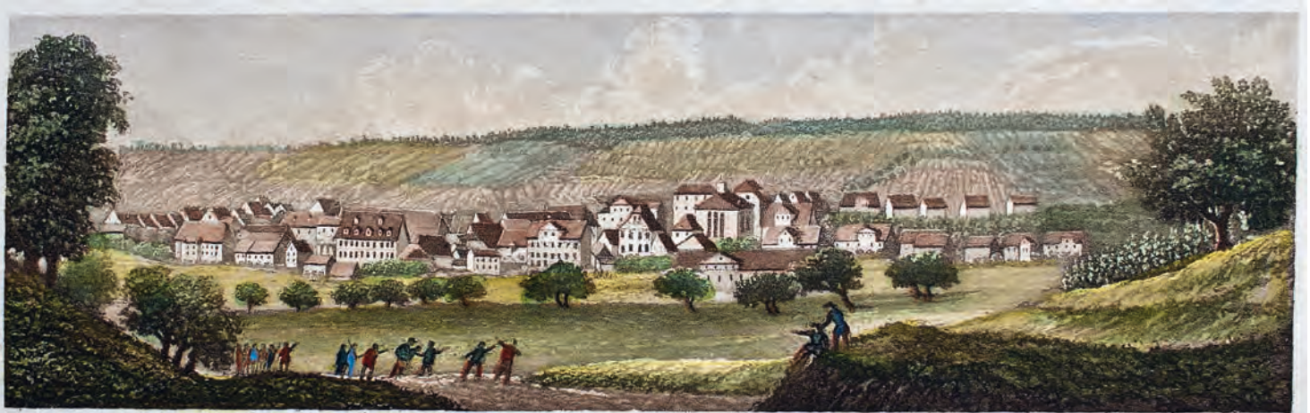
Korntal von der Südseite.
