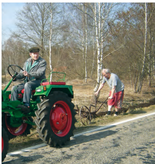
Mit ihrem Einschar-Pflug ziehen die Brüder Fritz und Josef Scholz straßenparallele Furchen, in die später die Folienzäune eingelegt werden.
