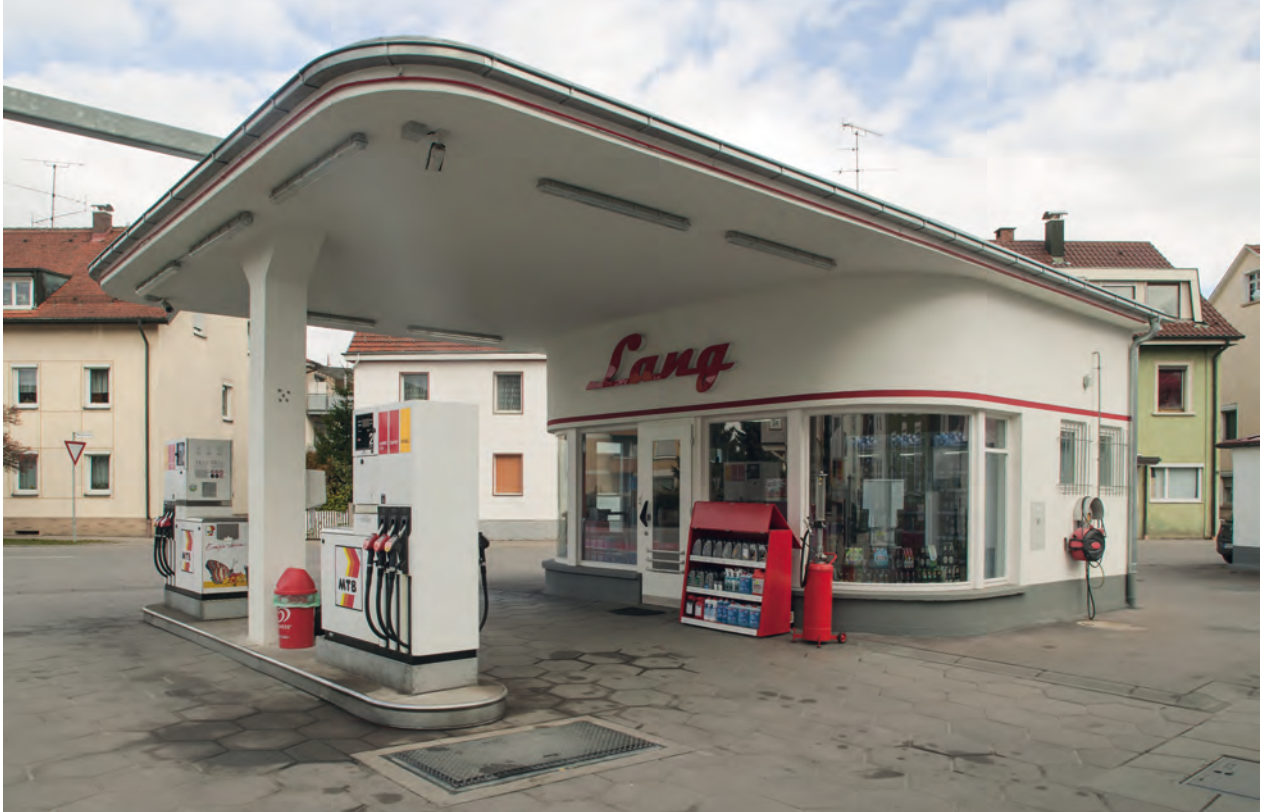
Ein äußerst rar gewordenes Dokument der Verkehrsgeschichte des 20. Jahrhunderts und immer noch in Betrieb: die sanierte Tankstelle in Tettngang.
