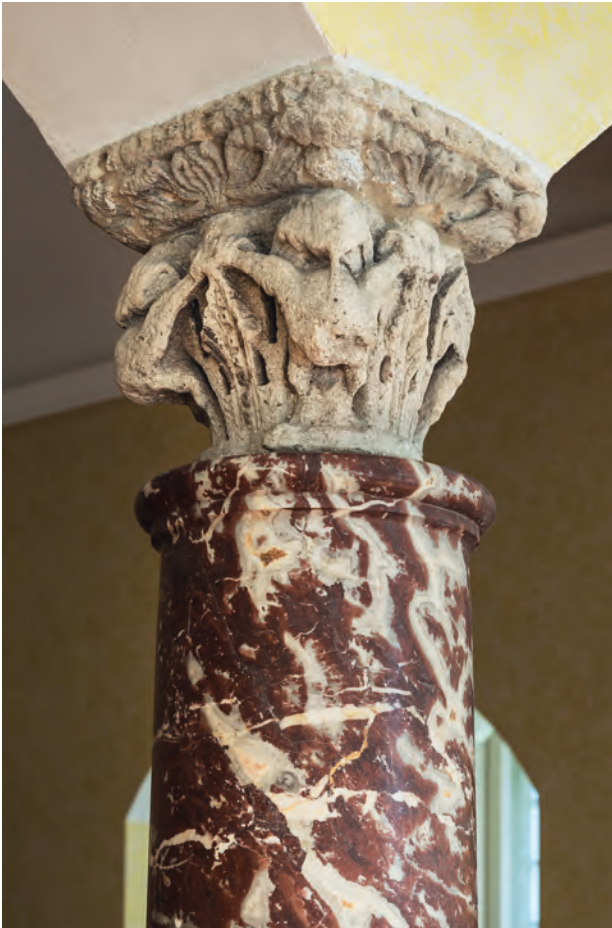
Eine Säule aus Böttinger Marmor von der Schwäbischen Alb bei Münsingen mit einem antiken Kapitell aus Ostia trägt die zwei flachen Bögen, die den Anbau vom Saal trennen.
