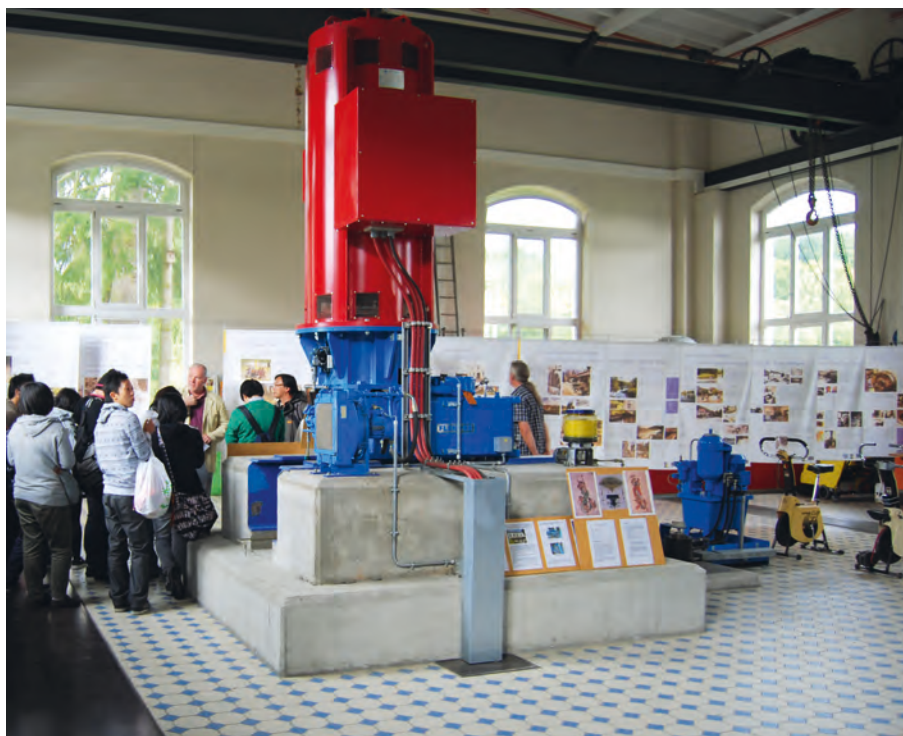
Das Wasserkraftwerk Obermarchtal-Alfredstal in der Donau wurde 1903 donauabwärts unterhalb des Barockmünsters erbaut. Noch heute sind die roten Generatoren aktiv. Seit 2004 ist dort zudem die Ausstellung «MuM – Maschinen unterm Münster» zu sehen.
