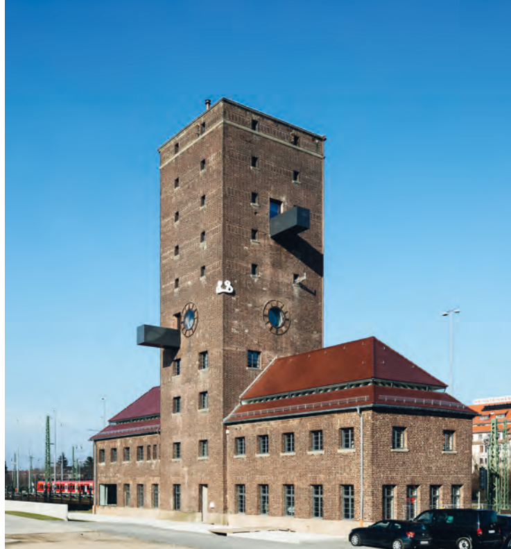
Ein eindrucksvolles Beispiel für die sachliche Monumentalität von Funktionsgebäuden der 1920er-Jahre: der ehemalige Bahnwasserturm in Heidelberg nach seiner Sanierung und Umnutzung.
