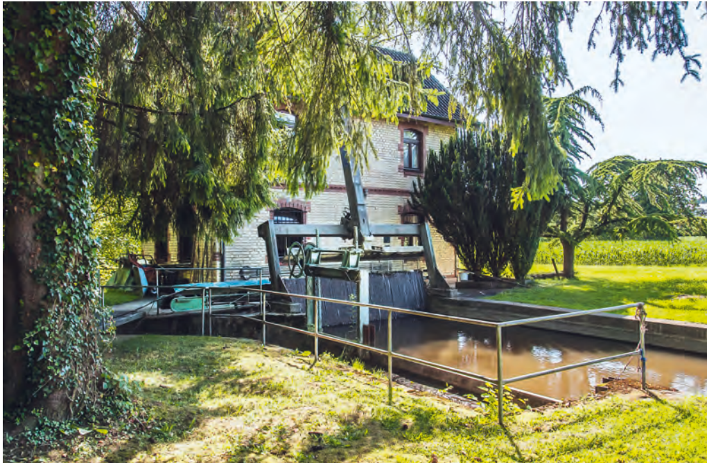
Das Krafthaus des Wassertriebwerks Berg-Kasernen an der Schussen von 1910, davor die Gitterstäbe des «Rechens». Inhaber Karl Eyrich hat 2016 Pläne für einen Umfließungsbach für Fische mit über 200 Liter Wasser pro Sekunde vorgelegt.
