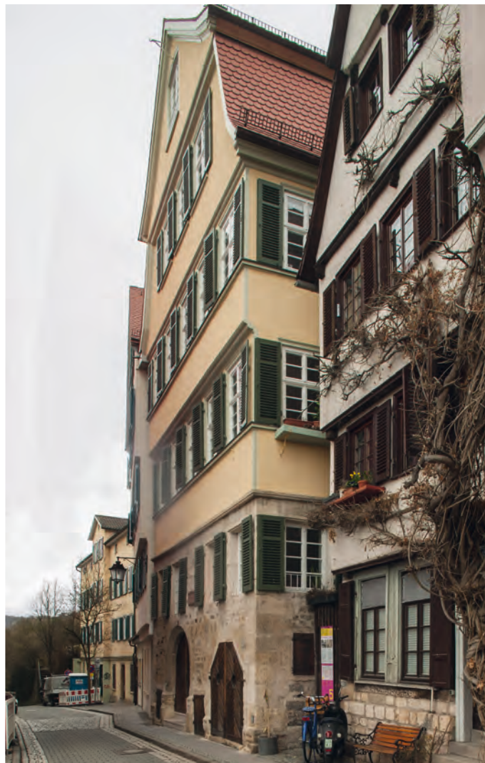
Wieder ein Schmuckstück in der Häuserzeile der Neckarhalde in Tübingen: Das Uhland-Haus nach der Restaurierung durch eine Bauherrengemeinschaft.
