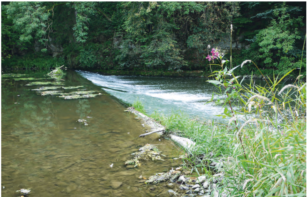
Das alte «Gaismühlen-Wehr» in Satteldorf im Kreis Schwäbisch Hall. Sowohl der Bürgermeister als auch der Gemeinderat sprachen sich für den Erhalt aus. Das Umweltzentrum Schwäbisch Hall fand die Zerstörung des Wehrs bedauerlich.
