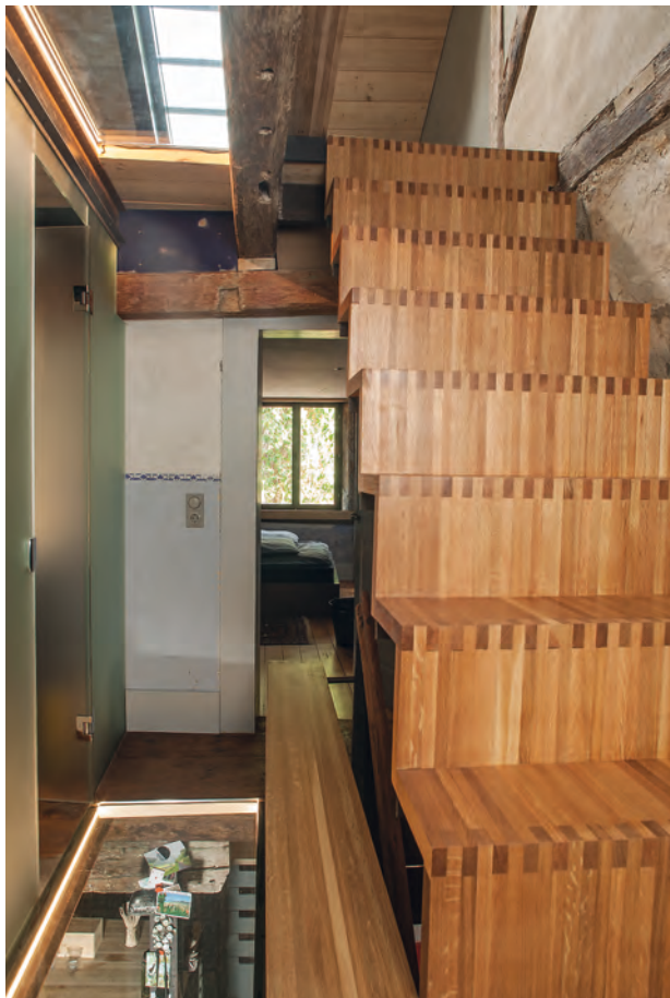
Durch ein von außen nicht sichtbares Dachfenster und Glasböden im Hausinneren fällt Licht bis ins Erdgeschoss.
