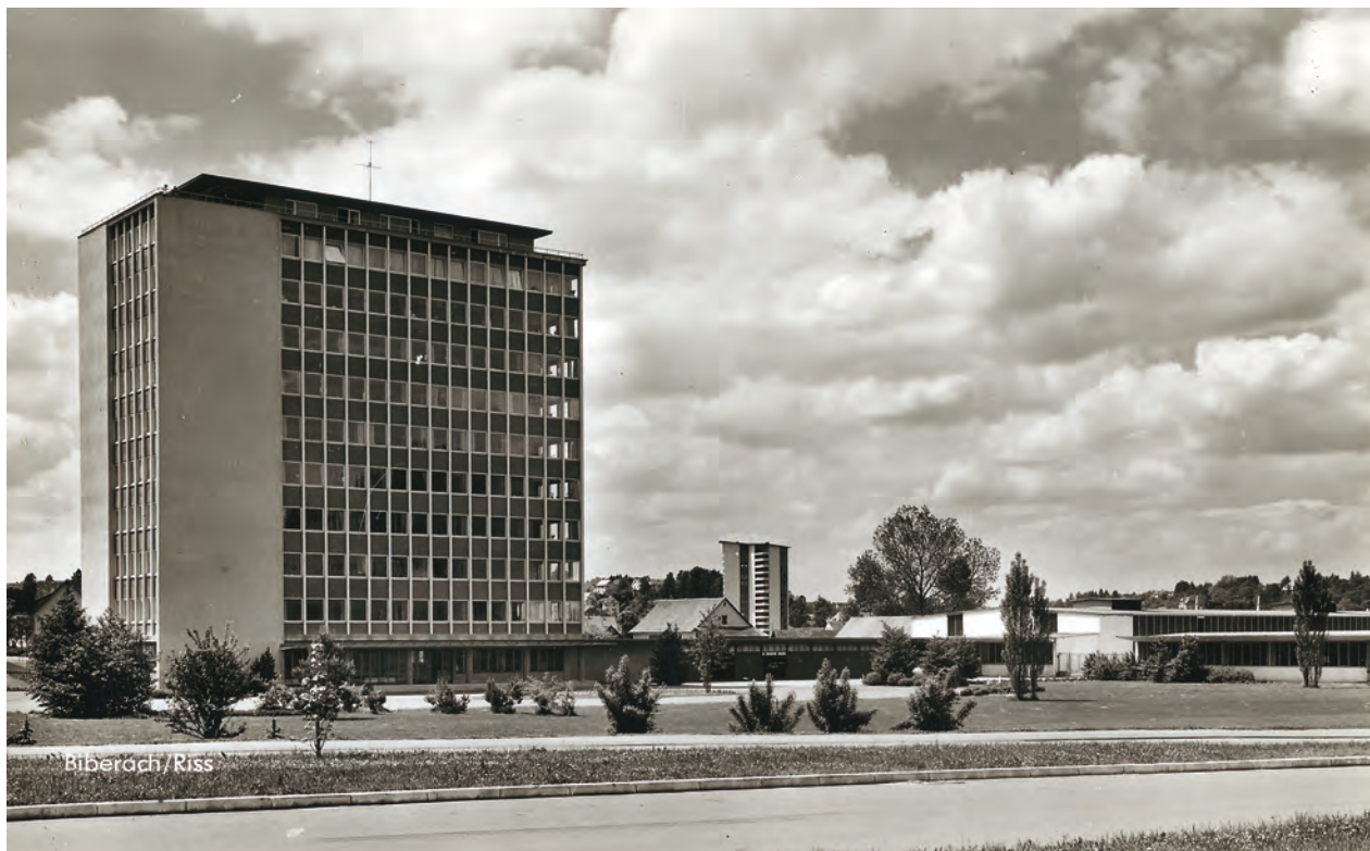
Die 1956 bezogene Hauptverwaltung der Firma Hans Liebherr Kranenbau GmbH in Biberach in den 1960er-Jahren. In das oberste Stockwerk zog der Firmengründer mit Familie ein. Im Hintergrund das 1957 bezogene Liebherr-Hochhaus.
