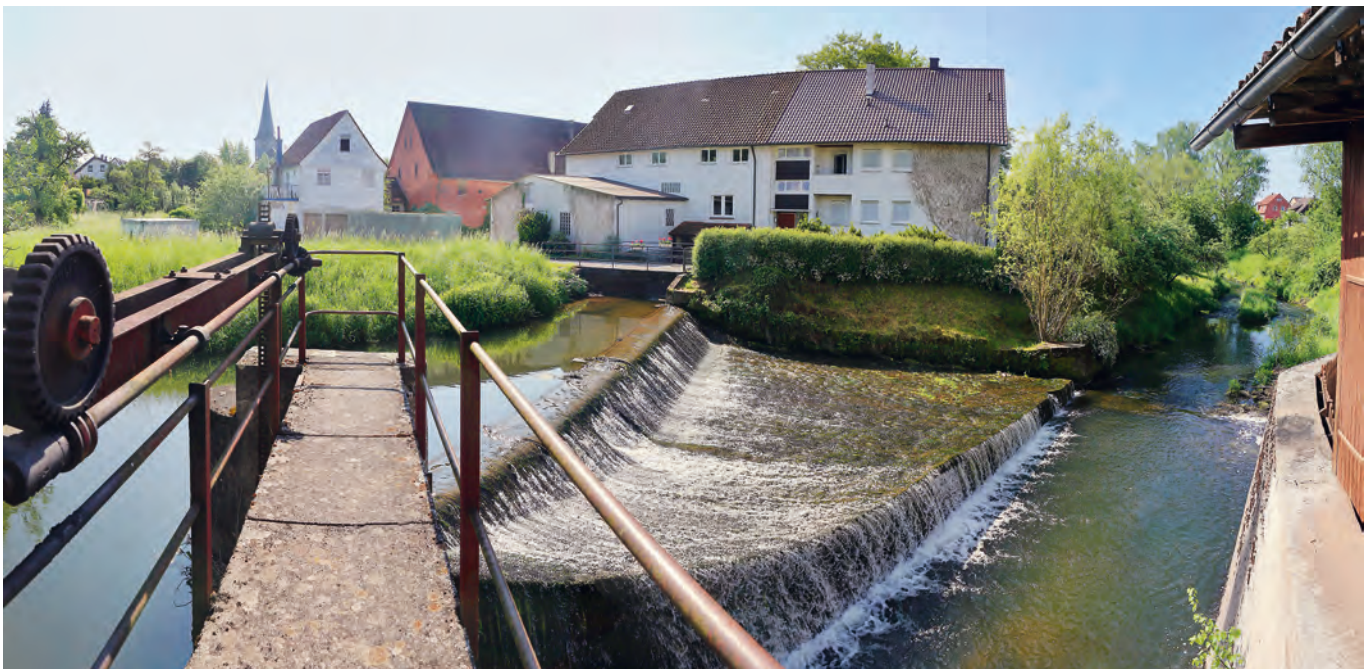
Blick auf das Stauwehr der Haubersbronner Wieslaufmühle bei Schorndorf. Die «BürgerInnen-Energie-Genosschaft Remstal eG» möchte das Wehr so umgestalten, dass es Fische überwinden können. Gleichzeitig soll das Wassertriebwerk verbessert werden.
