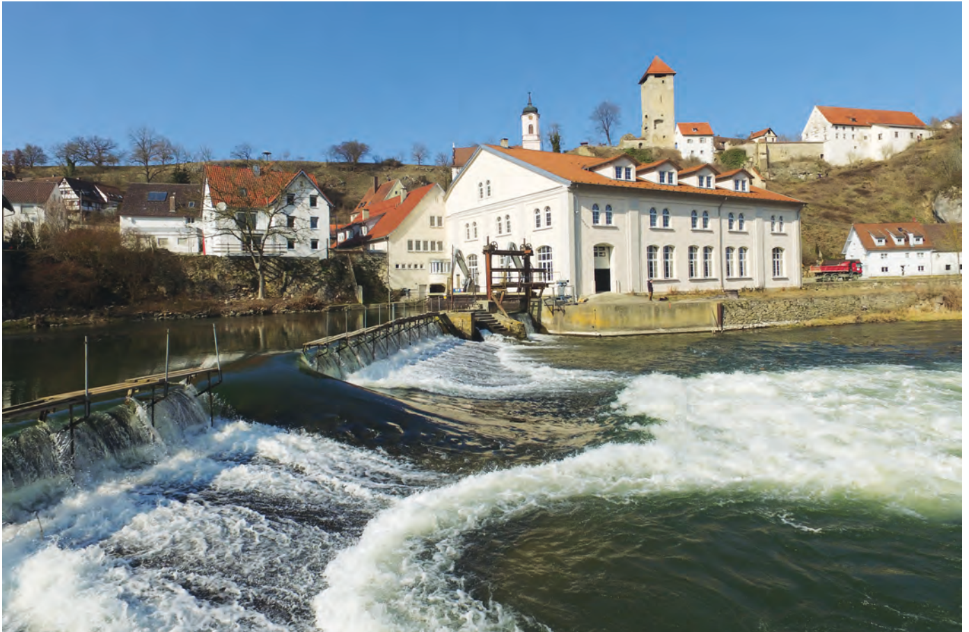
Blick vom Süden auf das im Kern noch aus dem Mittelalter stammende Donauwehr Rechtenstein südwestlich von Ulm 2016. Das daran anschließende, 1905 eine Mühle ersetzende Wasserkraftwerk vor dem Burg- und Kirchturm diente bis 1993 einer Holzschleiferei. Die Generatoren liefern heute noch Strom für über 1000 Privatleute.
