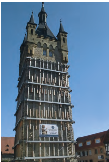
Notsicherung: Der Blaue Turm im Stahlkorsett.
