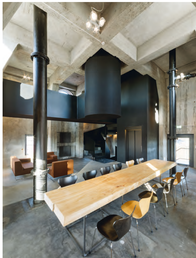
Die für die neue Nutzung im Wasserturm notwendigen Eingriffe, wie der Einbau von Treppe und Aufzug, lassen den rauen Charakter der alten Betonkonstruktion auch weiterhin zur Geltung kommen.
