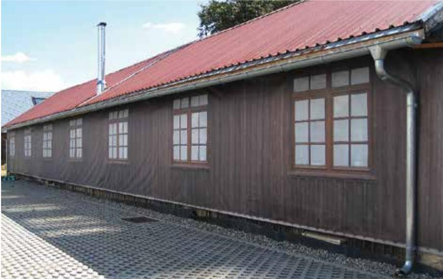
Abb. 23 - Ehemalige Wehrmachtsbaracke im Jahr 2020. Ein Kunststoffvorhang mit aufgemalter Fassadenstruktur und Fenstern überdeckt den teilweise maroden Zustand (Foto: Privat).
