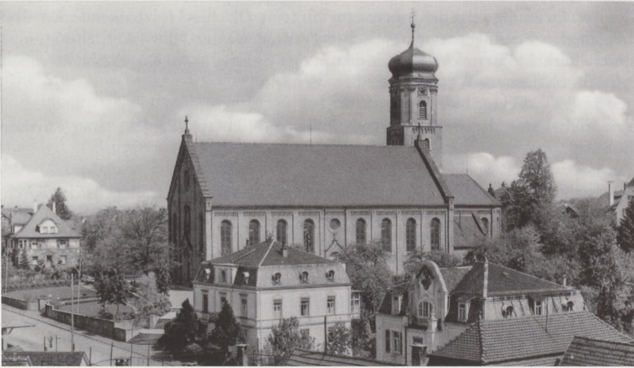
Abb. 10 - Tett nang, Katholische Pfarrkirche St. Gallus von Südwesten. Foto um 1930.
