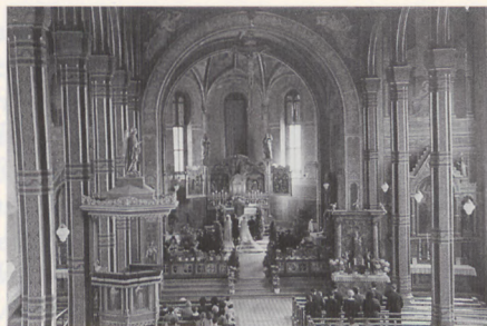
Abb. 11 – Tettang, Katholische Pfarrkirche St. Gallus, Inneres in Richtung Osten. Foto vor Beginn des Umbaus, ca. 1947.
