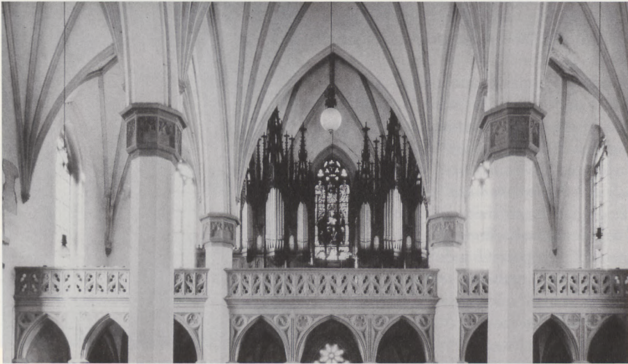
Abb. 8 - Leutkirch, Evangelische Stadtpfarrkirche, Innenraum nach Norden mit der durch alle drei Schiffe reichenden Orgelempore. Foto vor der Umgestaltung 1972/73.
