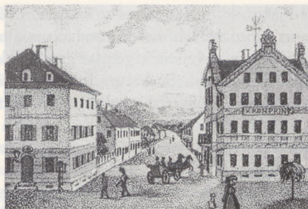
Abb. 1 – Ravensburg, ehemaliges Oberamtsgebäude (links). Zusammen mit dem einstigen Gasthof zum Kronprinzen (rechts) bildet das Gebäude den repräsentativen Auftakt der ab 1845 angelegten und in Richtung Süden führenden Seestraße. Teil eines Sammelbildes von Joseph Bayer, 1849. Kolorierte Lithographie. Privatbesitz.
