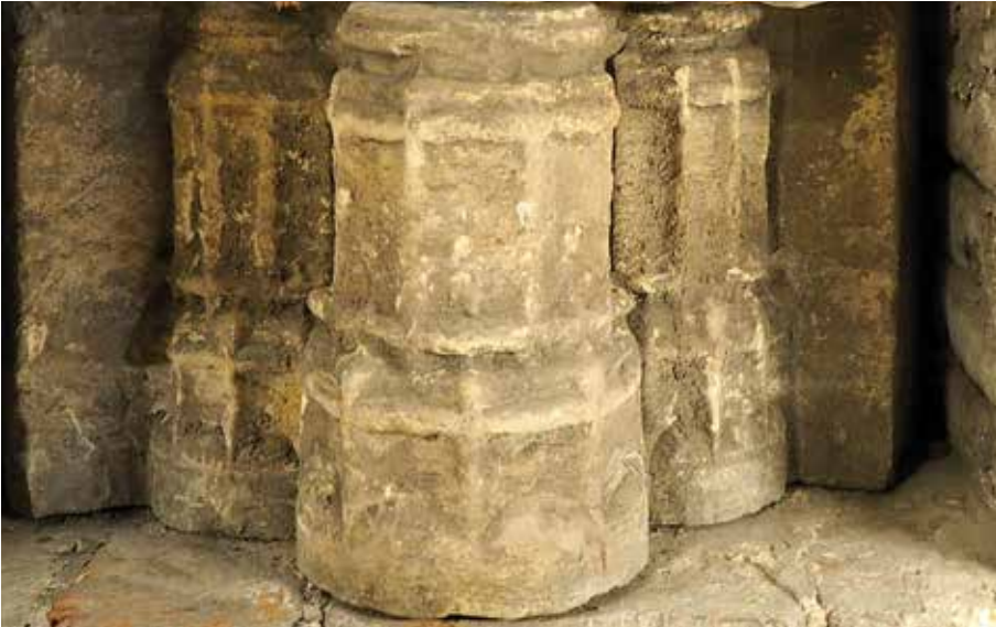
Abb. 6 - Ansicht Dienstsockel (Abb. 5) im Chordachraum Ulmer Münster Nordseite.
