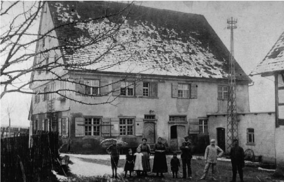
Abb. 6 - Die Marbacher Mühle Haug um 1911/12 – das E-Werk ist bereits in Betrieb (Strom-Mast mit Generator-Kammer rechts).
