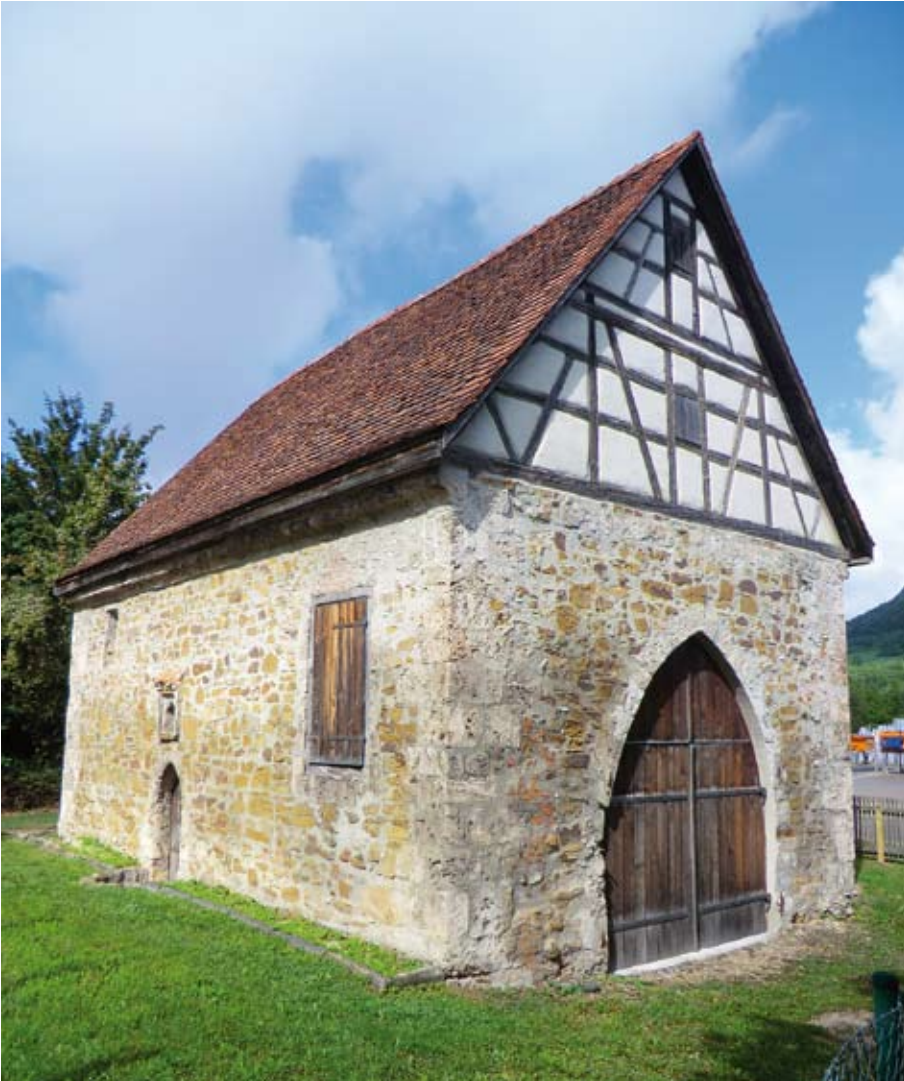
Abb. 4 - Die Siechenkapelle in Geislingen-Altenstadt nach der Restaurierung 2012 (StadtA Geislingen).
