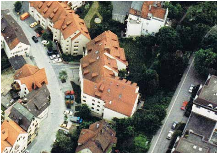
Abb. 32 - Luftaufnahme des Gebäudes Hämpfergasse 3-5 im Jahre 2020. Die Straße rechts im Bild ist die „Promenade“. Die linke Straße ist die Hämpfergasse in Richtung Fischergasse (Foto: Privat).
