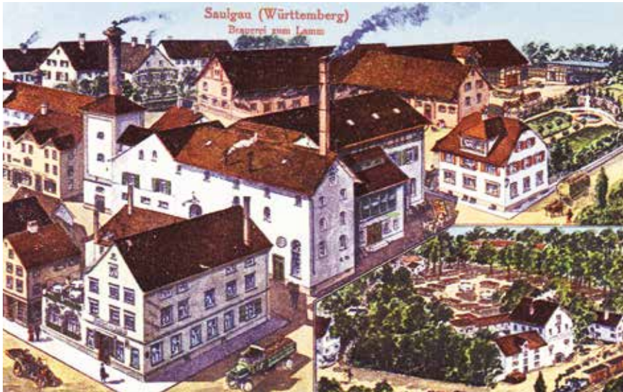
Abb. 3 - Die Lammbrauerei mit Mälzerei, Gasthof, Ökonomiegebäuden und Villa der Familie Fritz in Saulgau (Norbert Schuler, Mengen).
